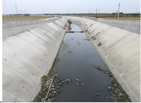
北鎮橋(無名橋 1-3)下游
