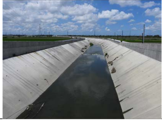
北鎮橋(無名橋 1-3)下游
