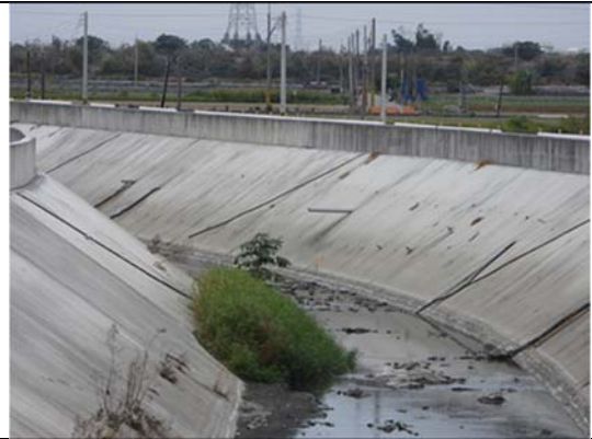
水岸及護坡照片
