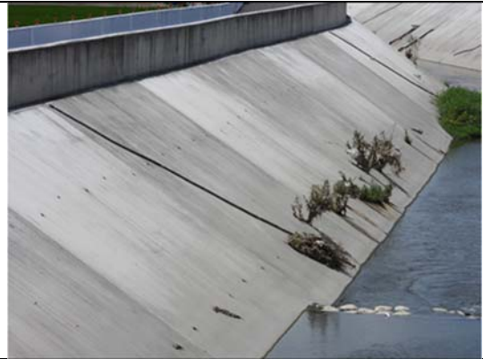
水岸及護坡照片
