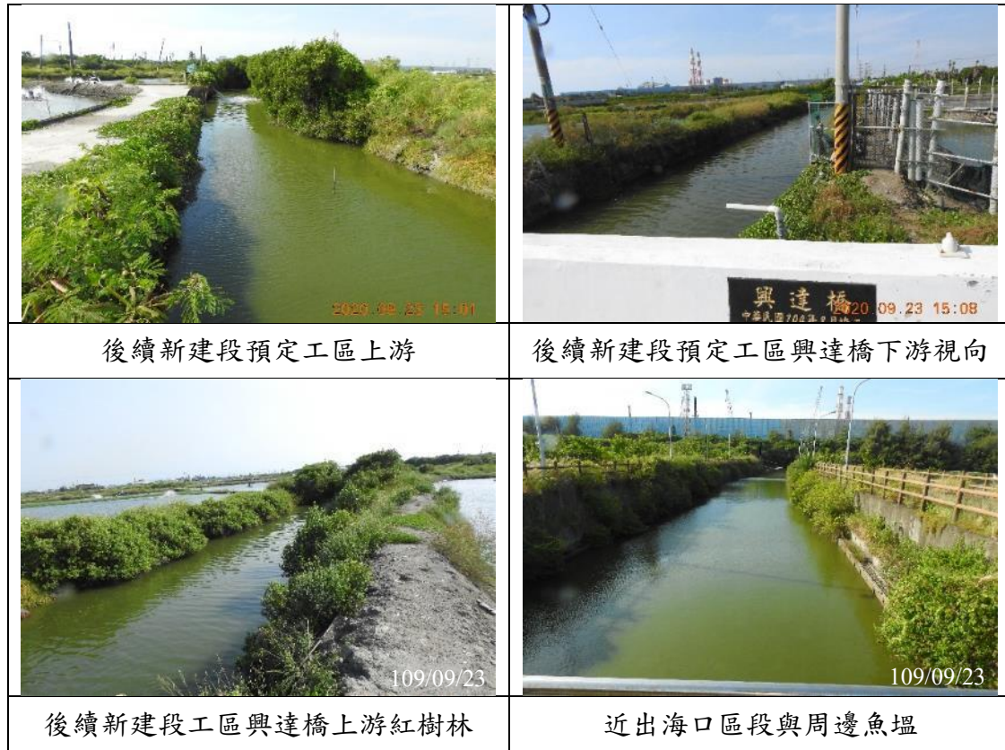
圖 4.7.1-3 「永安區北溝排水第三期護岸整治工程」預定工區施工前環境照
