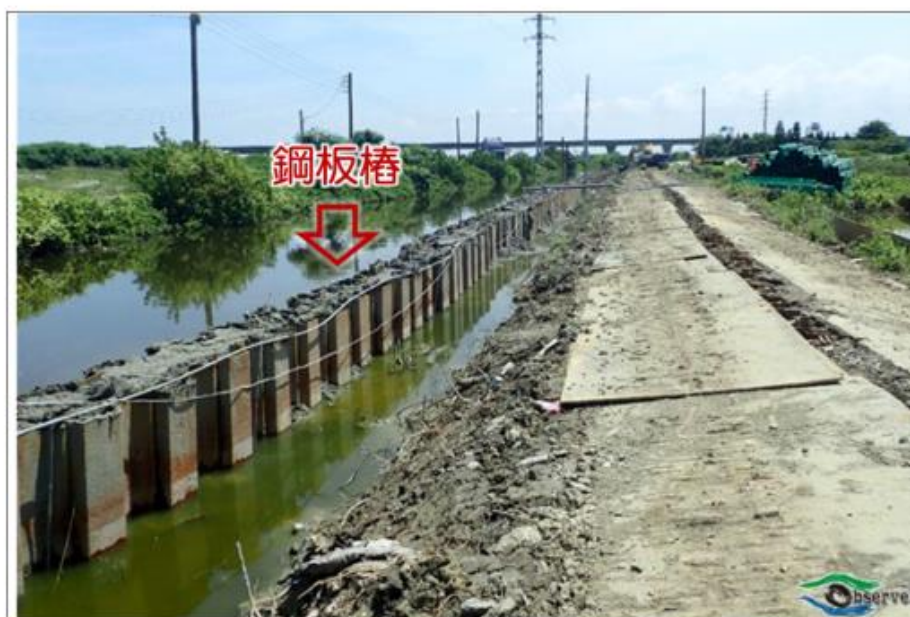
例圖二、施工期間設置鋼板樁隔離水體
