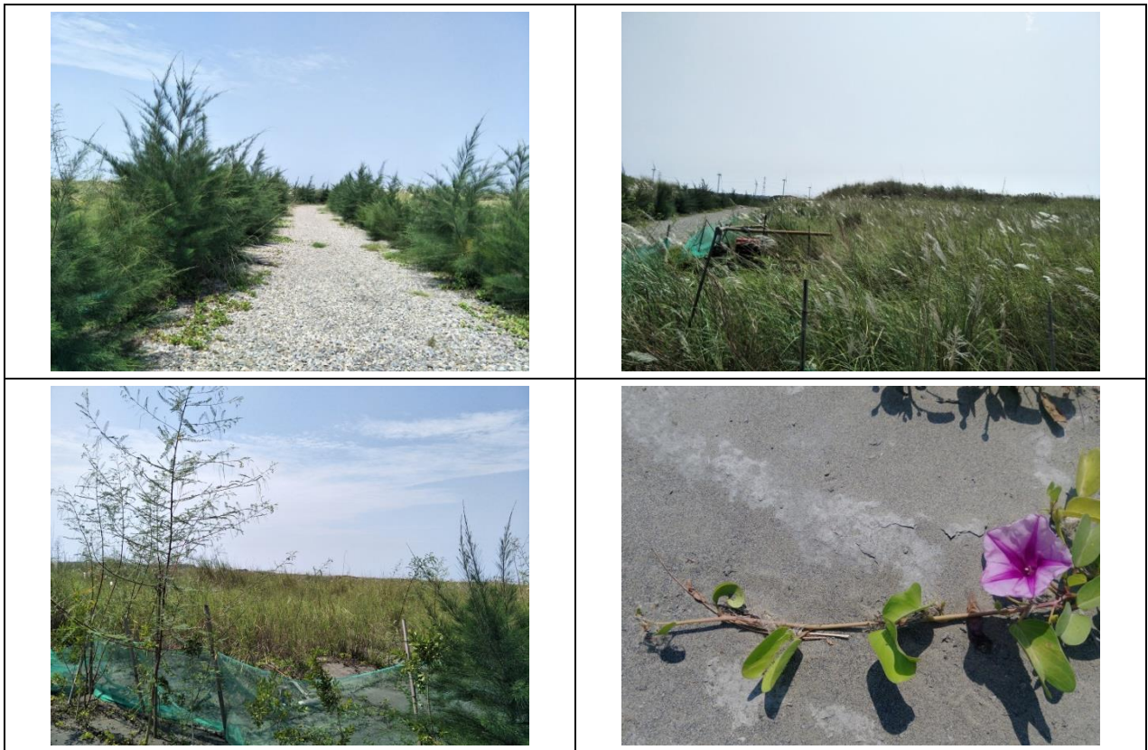
圖 4-1 濁水溪許厝寮堤段整建工程現況照
