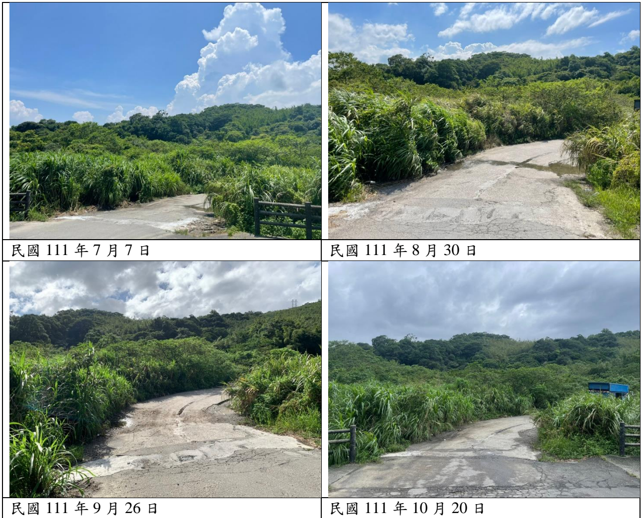
圖 3-9 「大武崙溪情人湖下游滯洪池」現勘環境照片(2/2)
