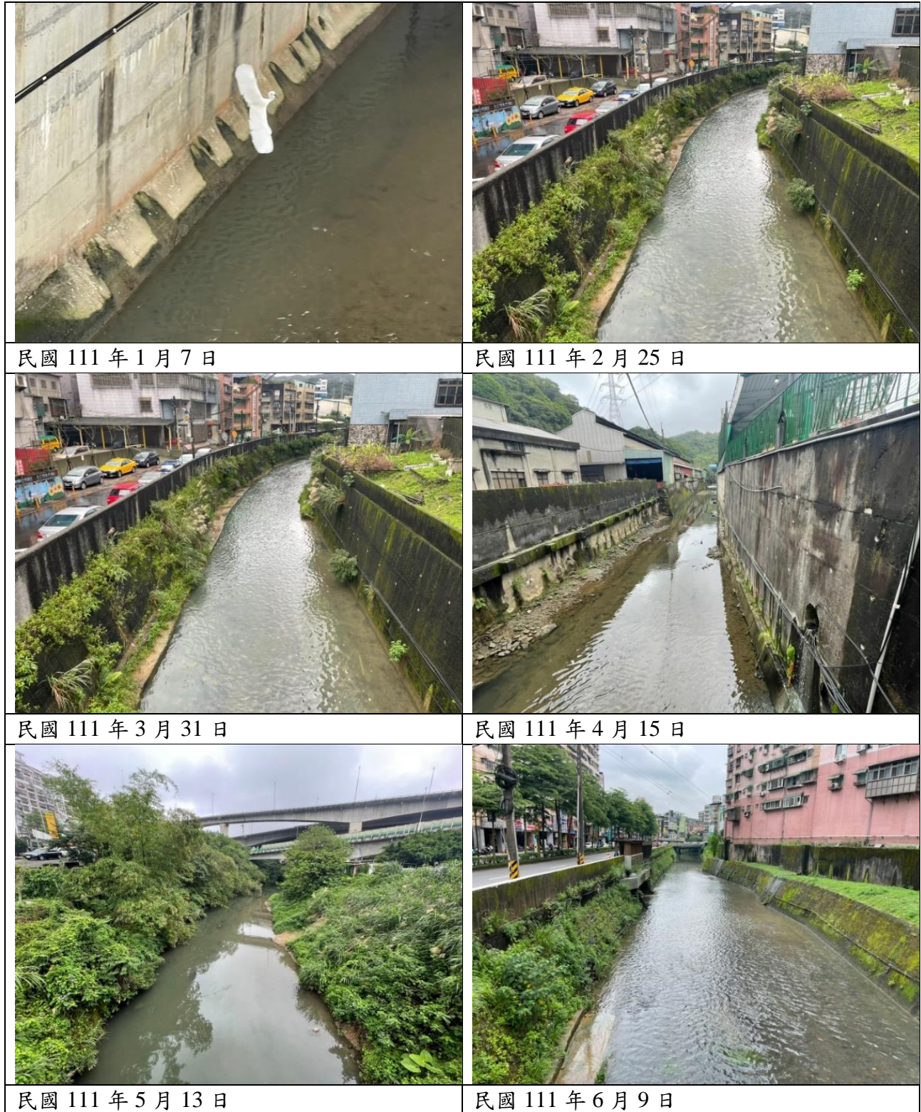
圖 3-18 「大武崙溪順興橋至民樂橋段改善工程」現勘環境照片(1/2)
