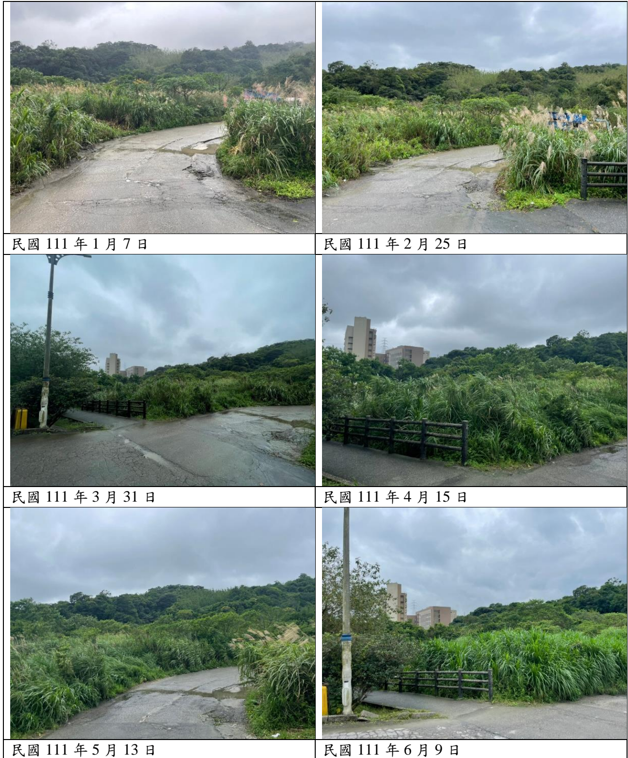
圖 3-8 「大武崙溪情人湖下游滯洪池」現勘環境照片(1/2)
