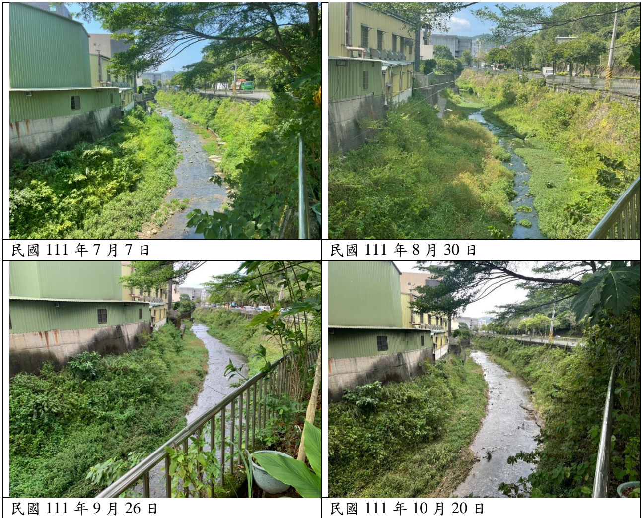
圖 3-5 「大武崙溪分洪道(入口處)」現勘環境照片(2/2)
