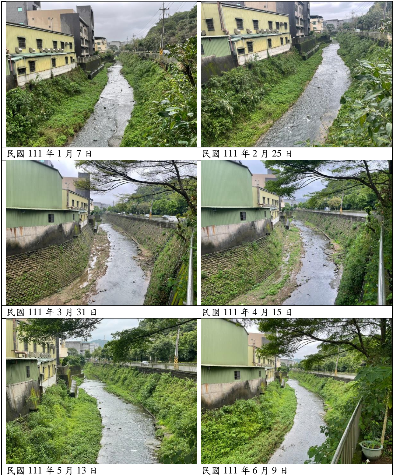
圖 3-4 「大武崙溪分洪道(入口處)」現勘環境照片(1/2)
