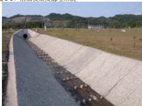
圖 2-25 掩埋場區內的排水明溝，圖中可見溝底的消能設計。
