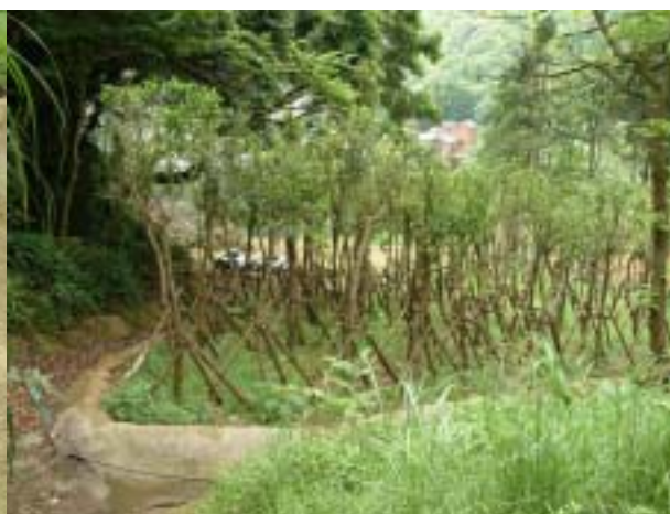
圖 2-17 打樁編柵區下方之木本植物護坡區。
