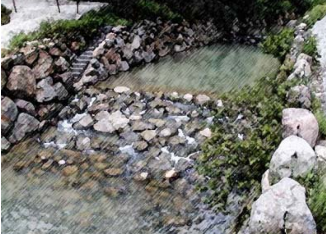
圖 7-17 砌石跌水工法實景示意圖
