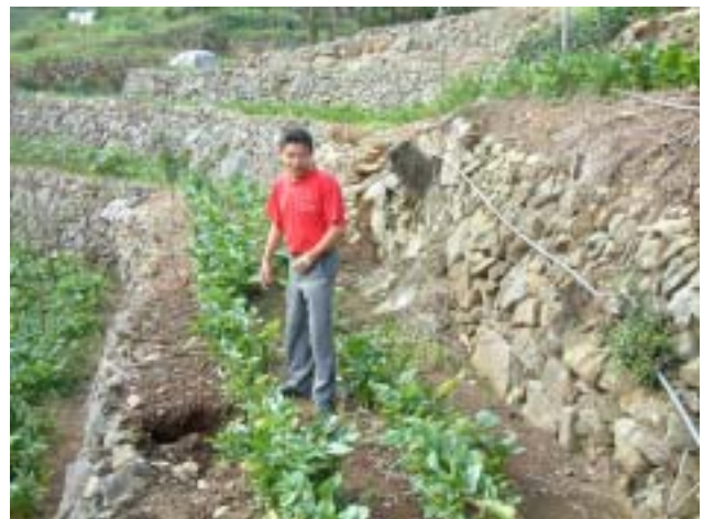
圖 5-23 竹子湖湖田里里長帶領工作人員勘查海芋田駁坎旁因豪雨沖刷形成之崩塌點。對當地居民而言，最關心的還是賴以維生的農作與生活所仰賴的基礎建設。
