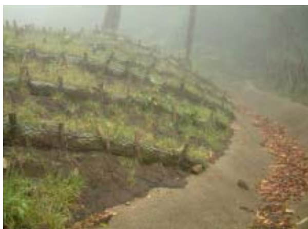
圖 2-14 位於「鄉村園」餐廳後方山區中之崩塌地生態工法整治區域現況。照片中可見整治區邊緣的排放逕流水用的噴漿 U 型溝。
