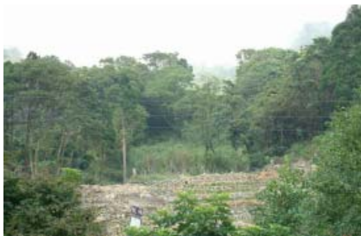
圖 5-24 由崩塌地下方鄉村園餐廳旁的馬路向上瞭望整治區，可以瞭解其位置之偏遠與環境全貌。
