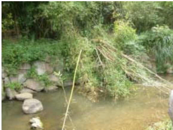
圖 5-1 大溝溪下游岸邊傾倒的竹子。圖中亦可見到護岸被植生覆蓋的情形。
