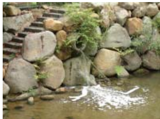
圖 5-21 大溝溪沿岸農戶直接將生活污水排入溪中之情形。這些都已經被在當地活動之居民看在眼裡。
