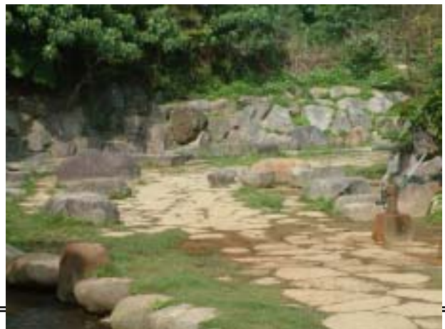
圖 2-6 大溝溪整治所採用的生態化 I 型/L 型原形石面護岸。圖左為下游段接近箱涵處的 I 型護岸，圖右是通過親水平台區後中游段的 L 型護岸。
