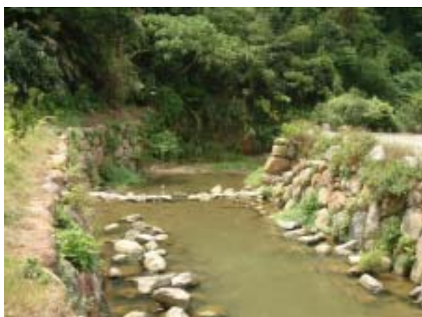
圖 5-6 大溝溪塊石護岸植生覆蓋現況。可以看出護岸表面以多少有植生自然生長，但仍與圖中後方較天然之河段有所差距。圖中亦可看出塊石大小及堆砌過於整齊的情形。
