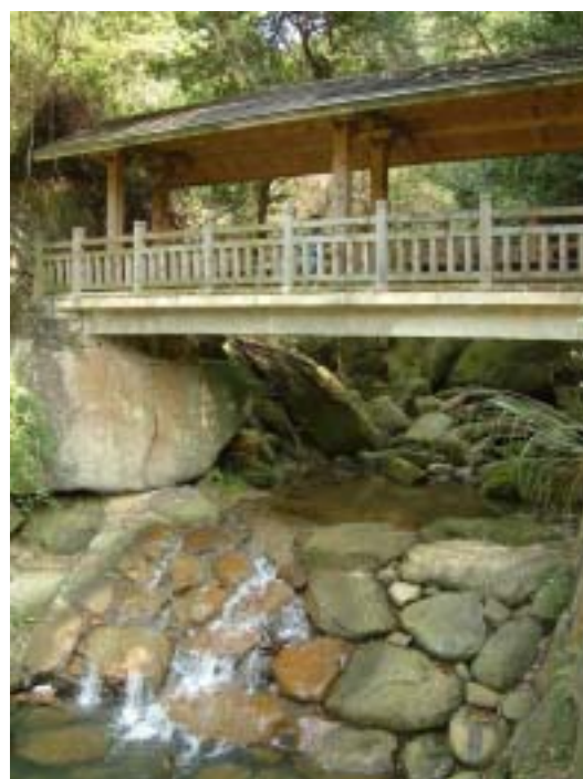
圖 2-5 大溝溪整治河段上游起點處的涼亭。涼亭下方水位落差較大處以堆石魚道的方式保留魚類棲息地。
