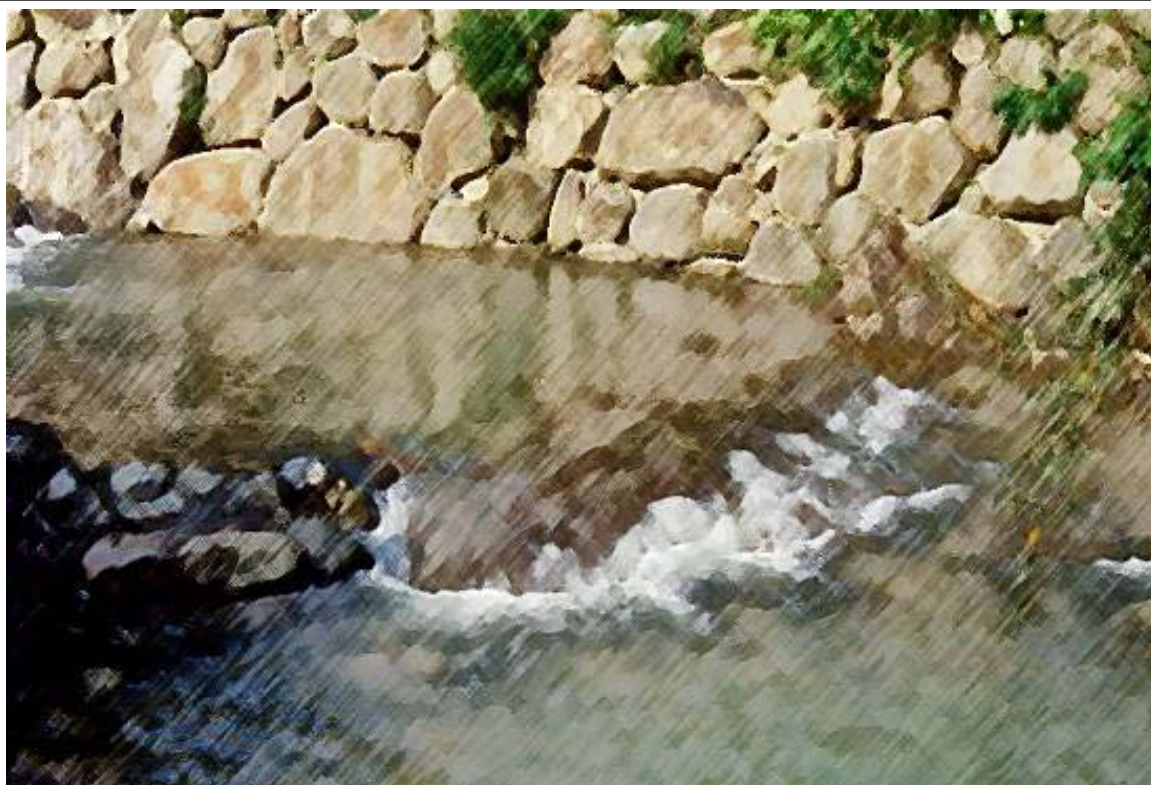
圖 7-23 湍瀨工法完工實景示意圖
