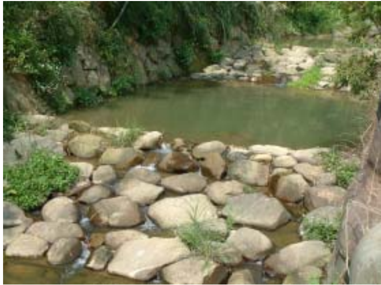
圖 2-8 於中上游坡降較大處所設置之連續的魚梯。
