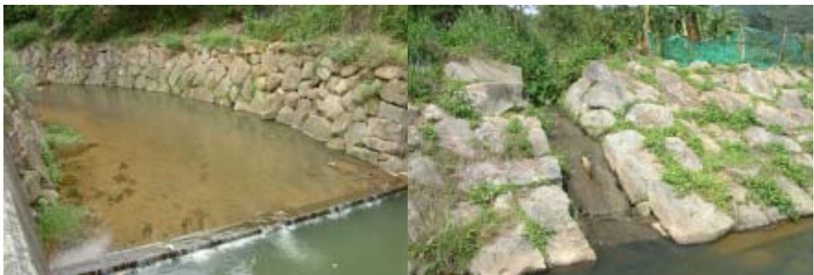
圖 2-6 大溝溪整治所採用的生態化 I 型/L 型原形石面護岸。圖左為下游段接近箱涵處的 I 型護岸，圖右是通過親水平台區後中游段的 L 型護岸。
