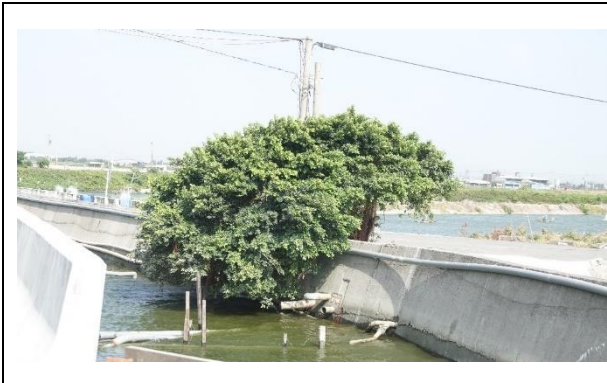
水岸及護坡照片
