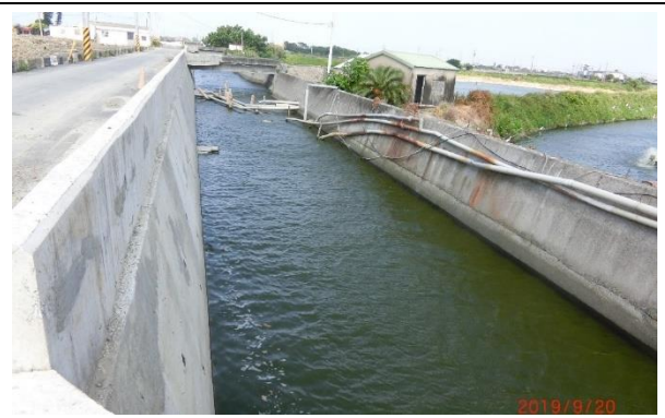
水岸及護坡照片
