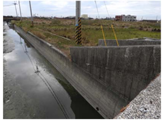
水岸及護坡照片(工區 A)
