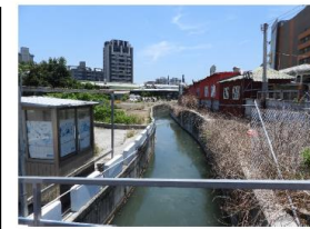
水岸及護坡照片
