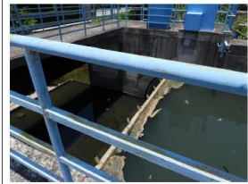
水岸及護坡照片
