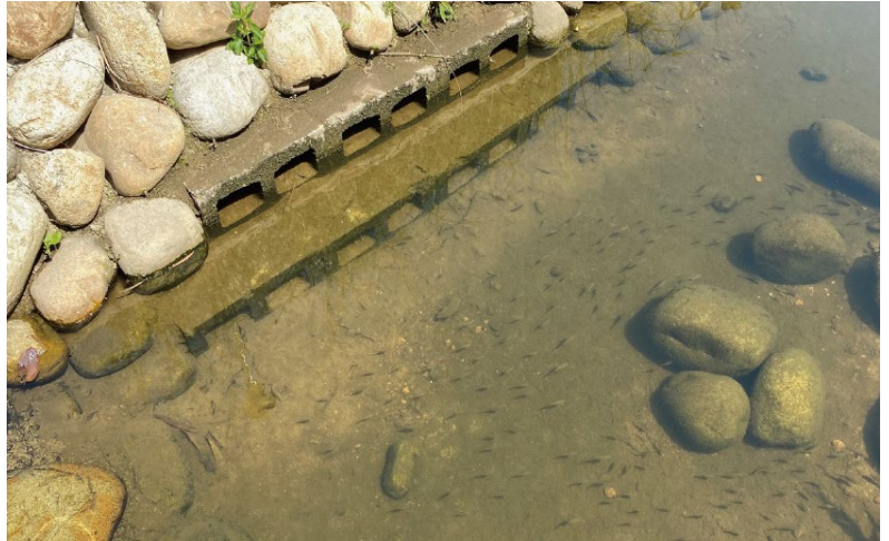
圖 46、護岸坡底部分設置魚洞
