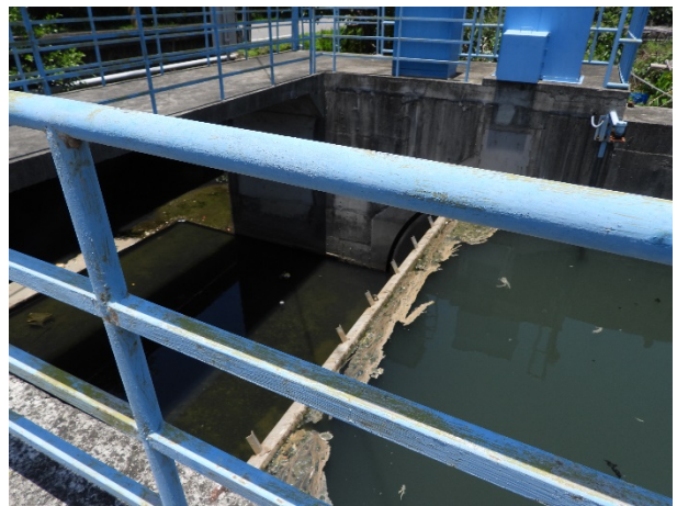
水岸及護坡照片
