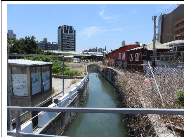
水岸及護坡照片
