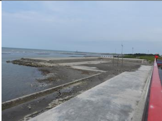
海岸及護坡照片
