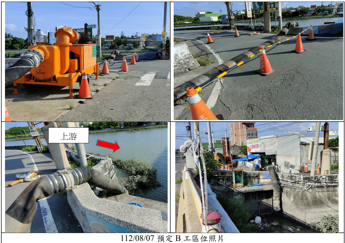
圖 3-5 芳苑鄉抽水機平台應急工程 B 環境現況照片
