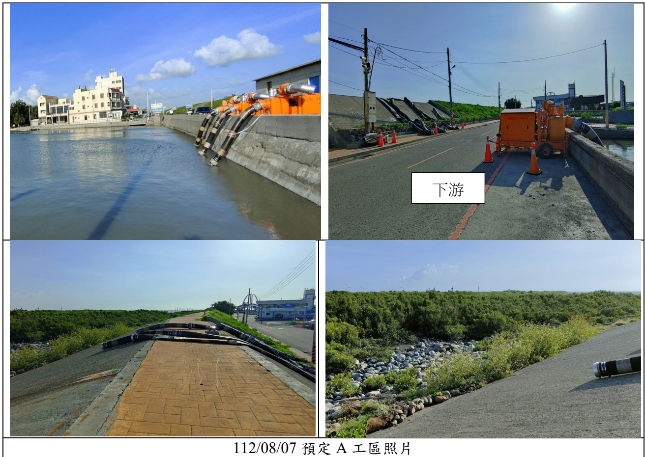
圖 3-2 芳苑鄉抽水機平台應急工程 A 環境現況照片
