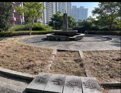
3. 既有水景設施硬體狀態佳，部分鋪面有破損。
