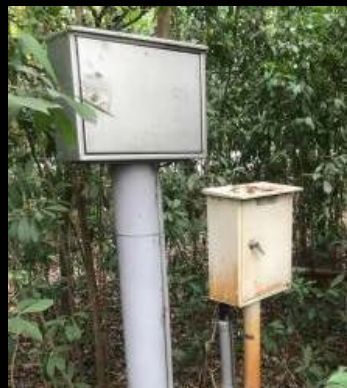
既有水井(一) 近沉砂池
