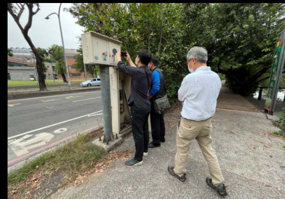
與機電專業廠商現場勘查、諮詢
