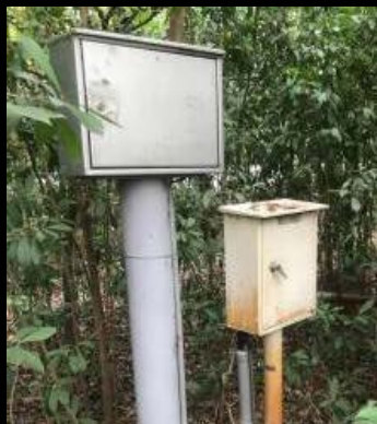
既有水井(一) 近沉砂池
