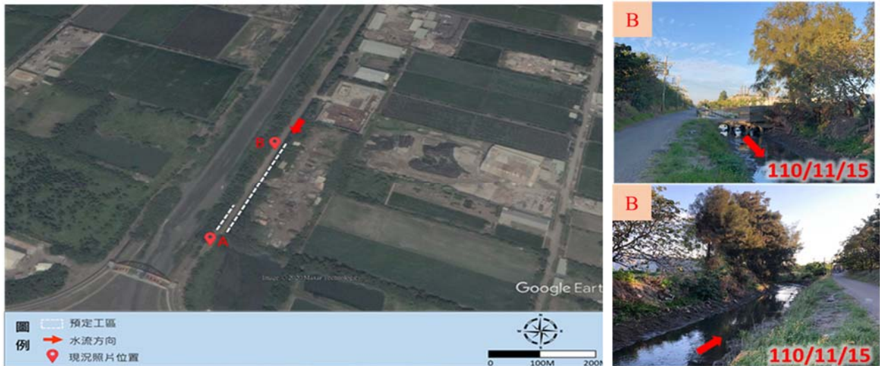
圖 6 港北金城橋排水幹線護岸新建應急工程(0K+090-0K+302)環境現況照
