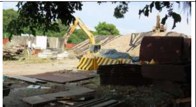
工作照-計畫路線施工處
