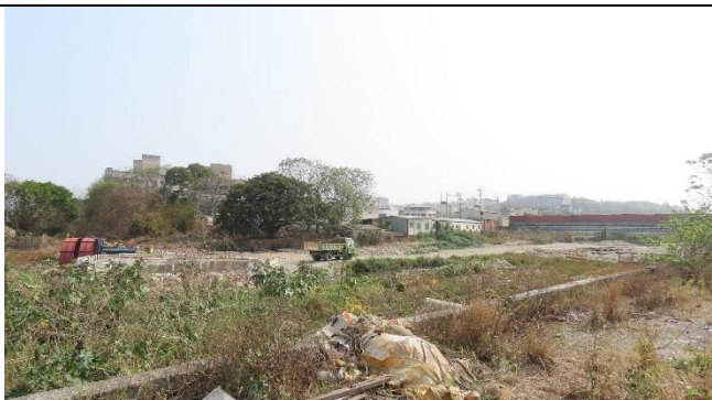
環境照-美村橋下游施工處
