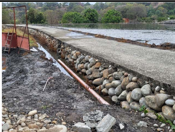
設置引水管線避免原有水路斷流 施工有盡量避開損壞既有邊坡
