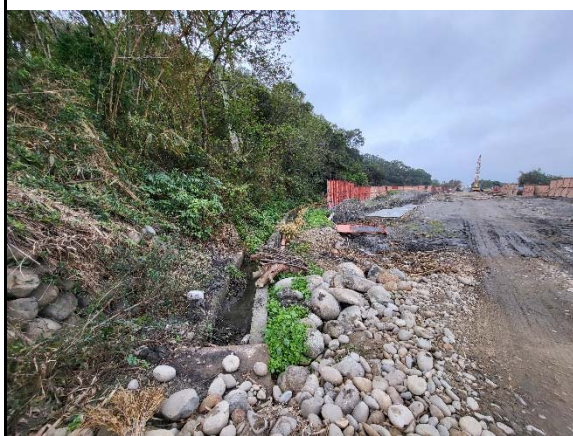
上方加蓋鋼板避免損壞山邊灌溉溝渠
