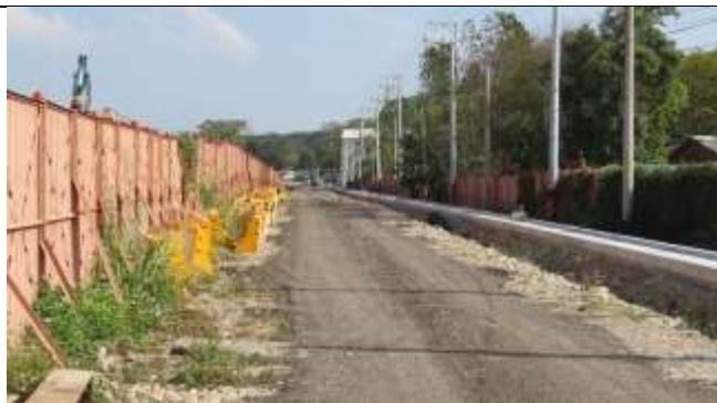
工作照-計畫路線施工處
