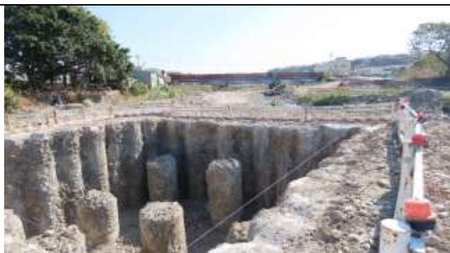
環境照-美村橋下游施工處
