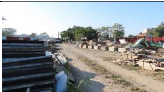
工作照-計畫路線施工處
