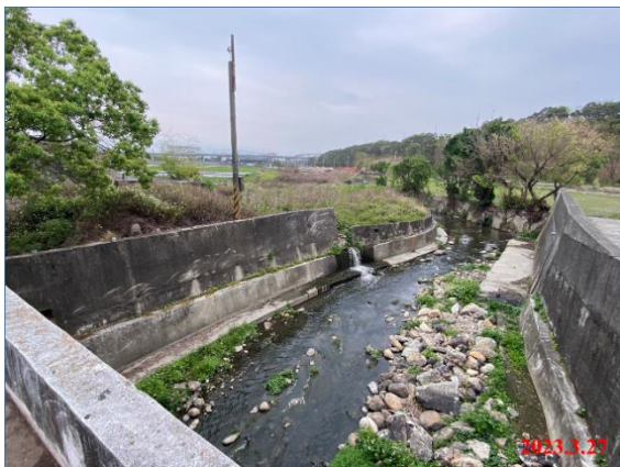
點位(7)現況照片(外埔排水)
