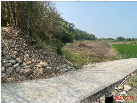
點位(7)現況照片(邊坡與灌溉溝渠)
