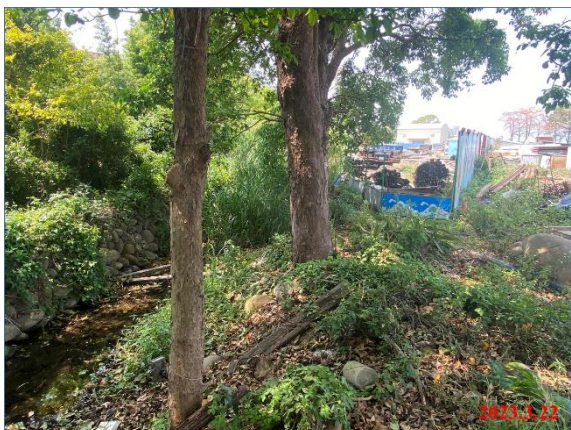
點位(1)現況照片(既有灌溉渠道)
