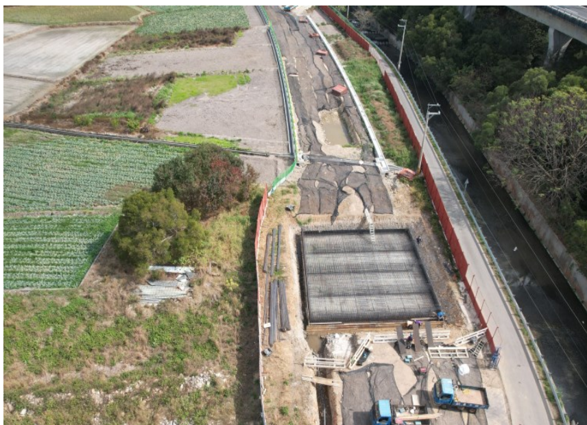
圖5.11：新建道路二側施工圍籬現況照片
