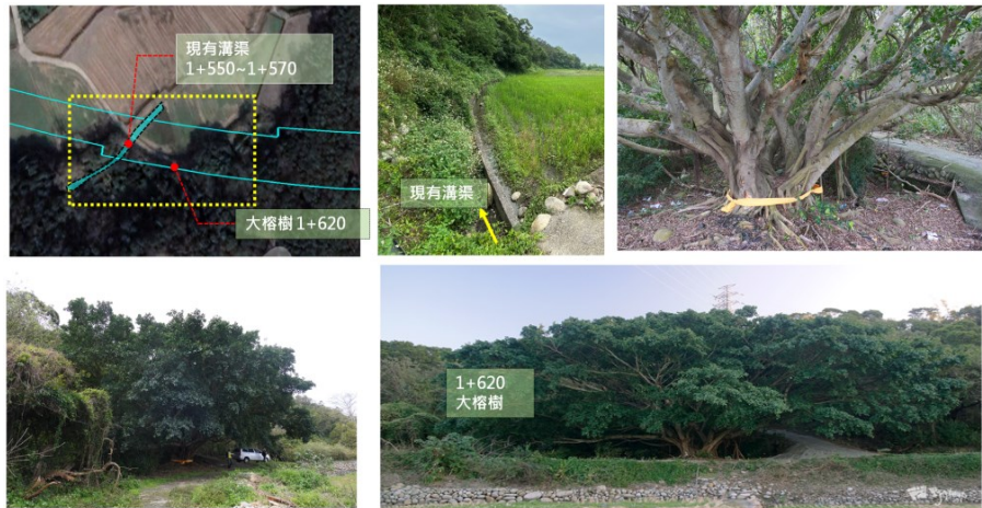
圖6.1：坡腳灌溉溝渠與大榕樹之現況照片
