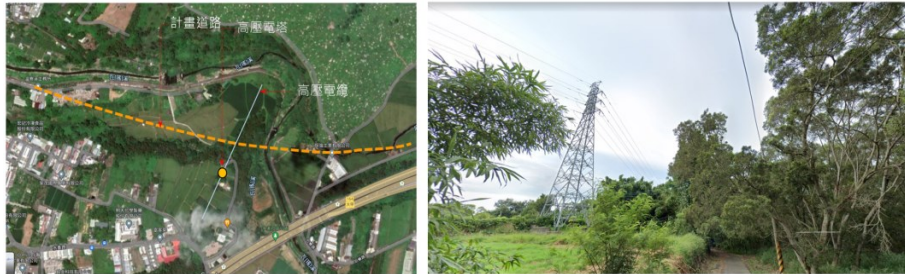
圖5.6：高架電塔現況照片
