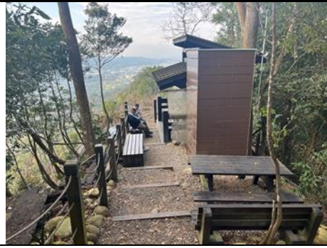
0.2K 處新設眺望平台 (229199, 2675703)
