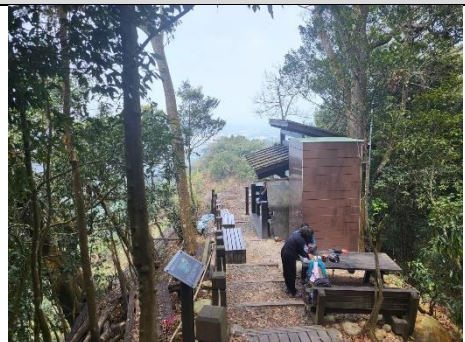
0.2K 處新設眺望平台 (229199, 2675703)
