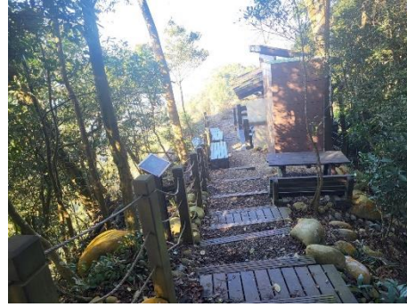
0.2K 處新設眺望平台 (229199, 2675703)
