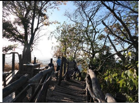
0.6K 處新設休憩眺望平台 (228777, 2675317)
