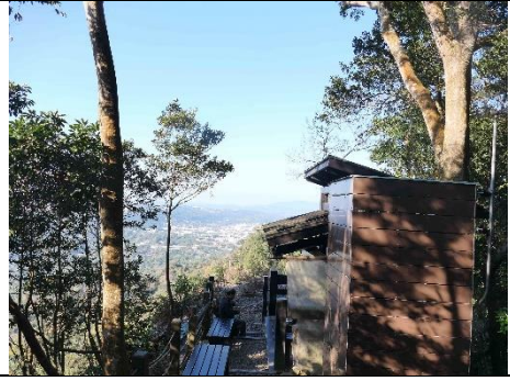
0.2K 處新設眺望平台 (229199, 2675703)
