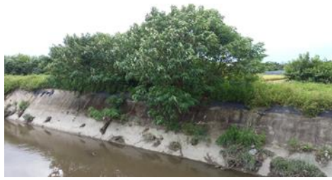
水岸及護坡照片
