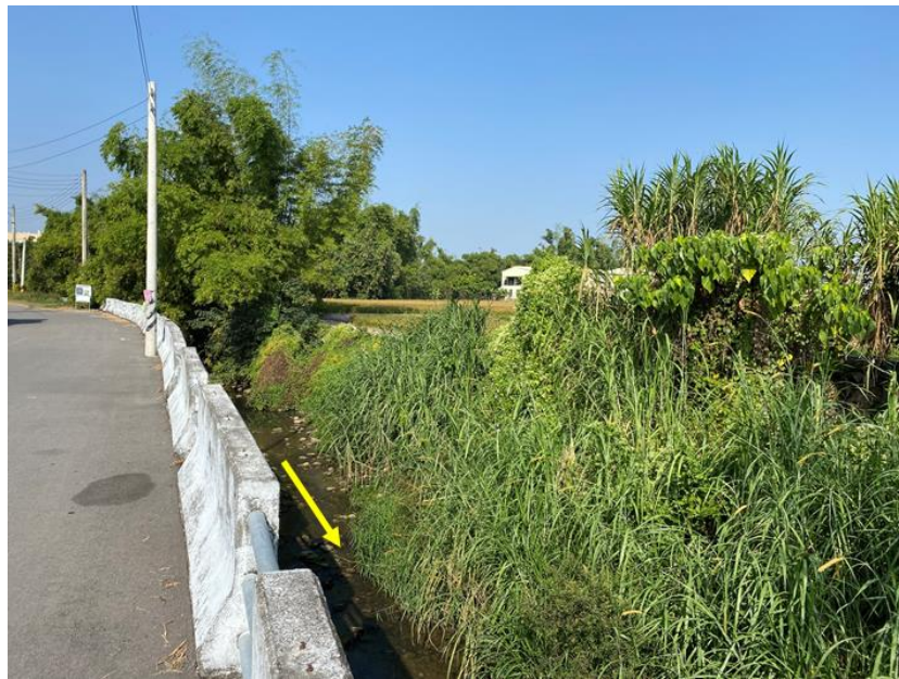
圖 2-53 塔蓮溝預定工程區域較下游段(神林路段)兩岸現況照片
