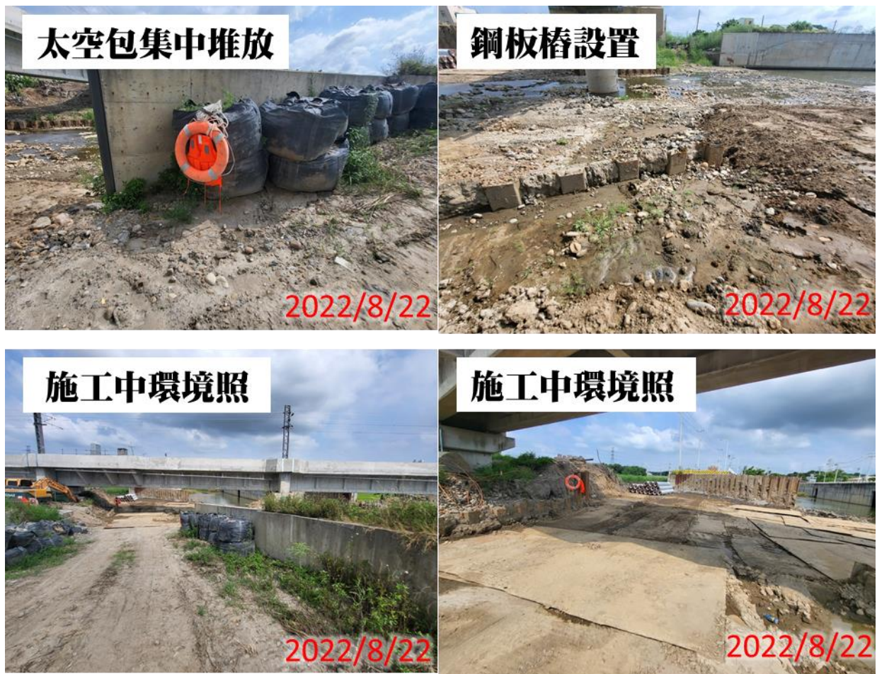
圖 2-47 龍井區山腳排水施工中環境照
