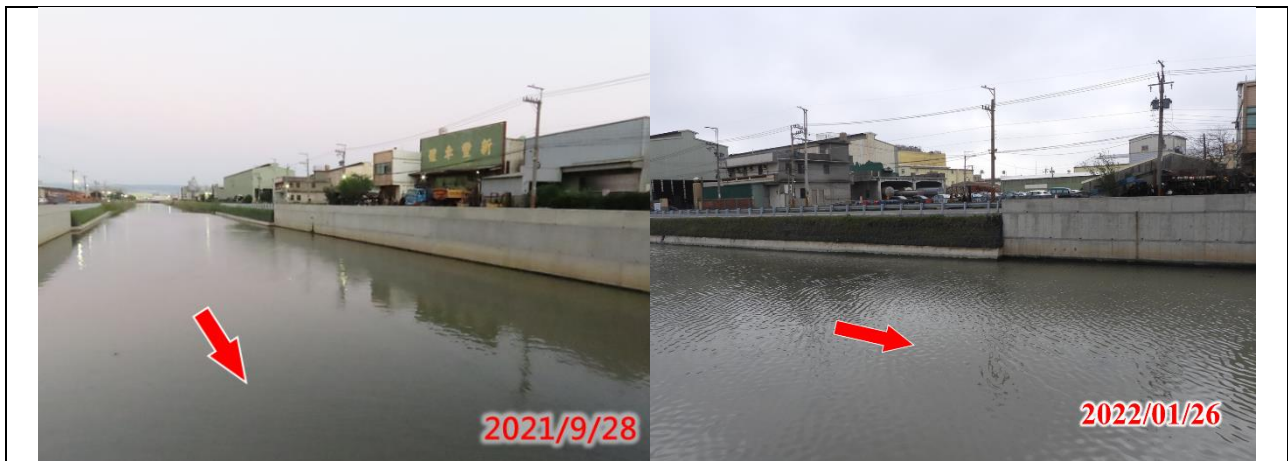
(D)水凝土護岸，較不利生物使用
