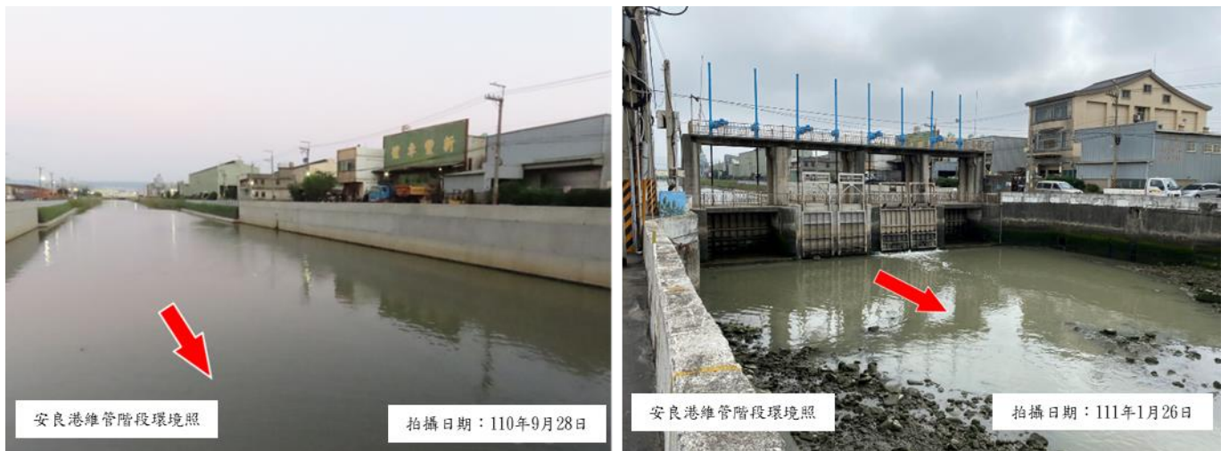
圖 2-76 安良港排水 0K+866-1K+547 治理工程併辦土石標售環境照
