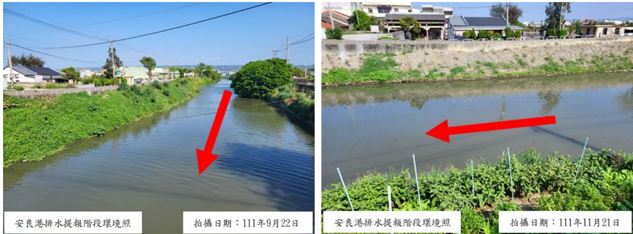
圖 2-86 臺中市梧棲區安良港排水 2K+584~3K+020 應急工程環境照
