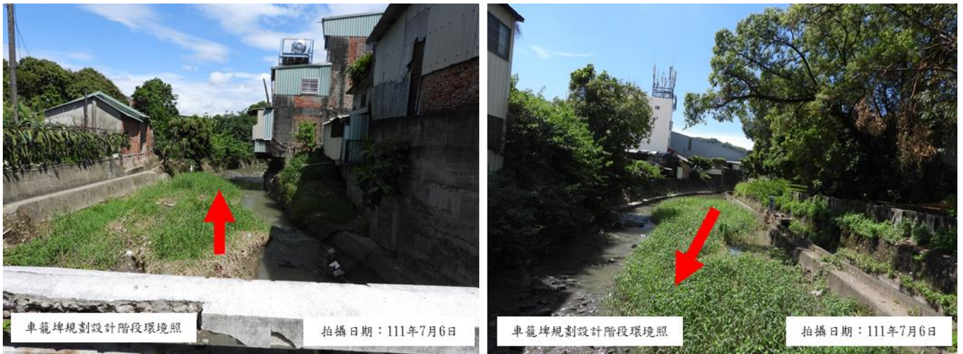
圖 2-9 車籠埤排水利農橋上下游護岸改善治理工程環境照
