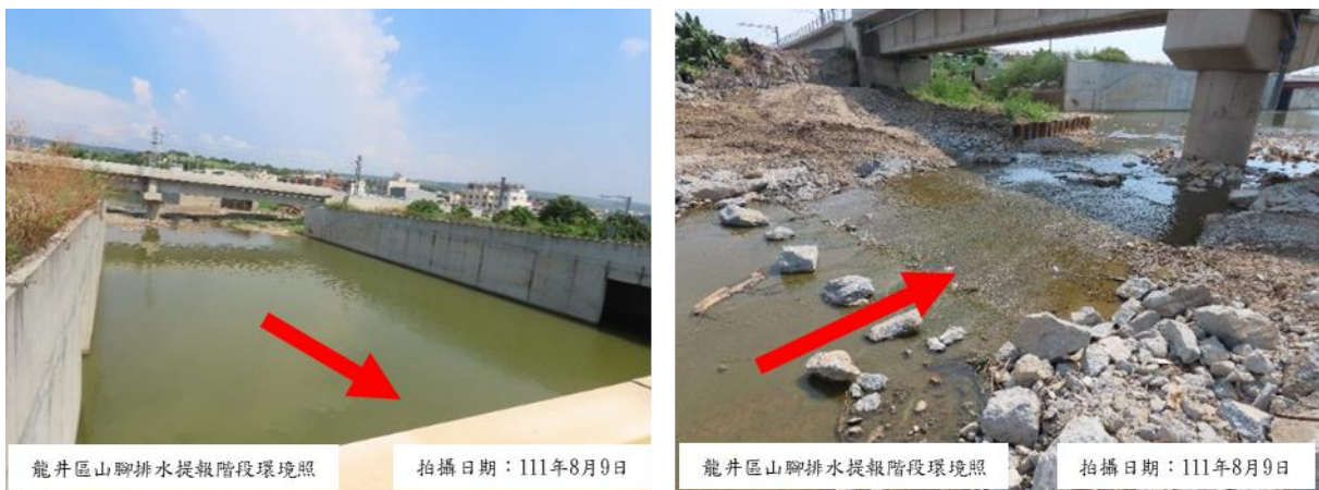
圖 2-42 龍井區山腳排水 4K+225~4K+330 工程環境照
