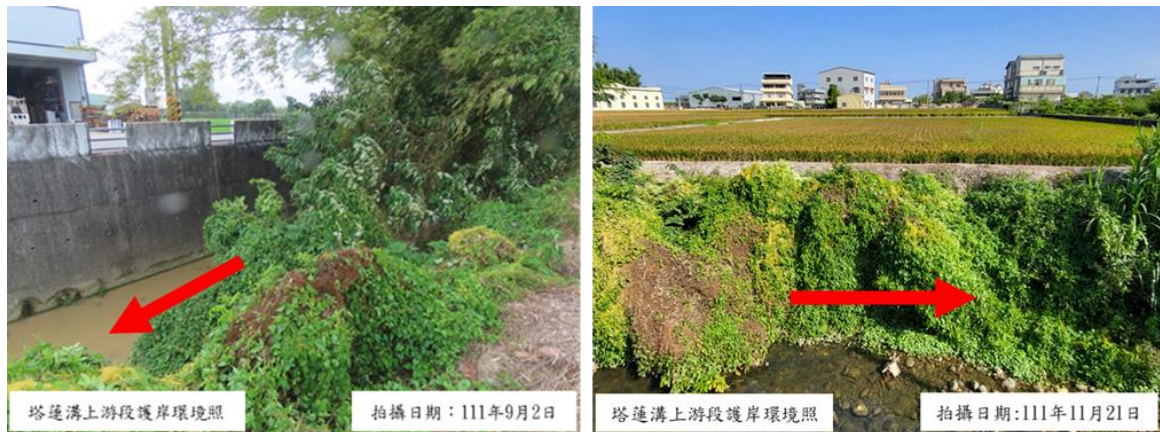
圖 2-49 大雅區塔蓮溝上游段護岸應急工程環境照
