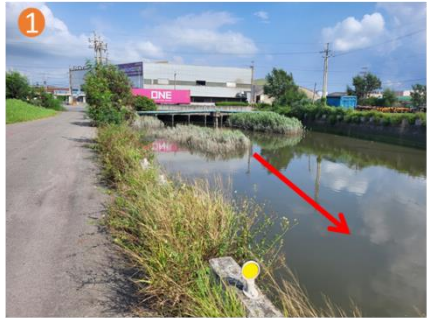
龍井區忠和中排水臨港路下游右岸護岸改善應急工程
