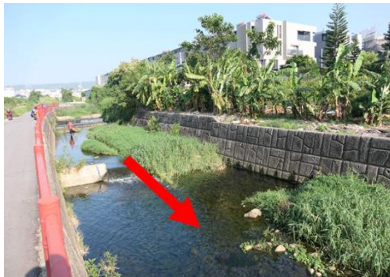
圖 2-96 南勢溪預定工程區域起點處(鄰汗水排放口)兩岸現況照片
