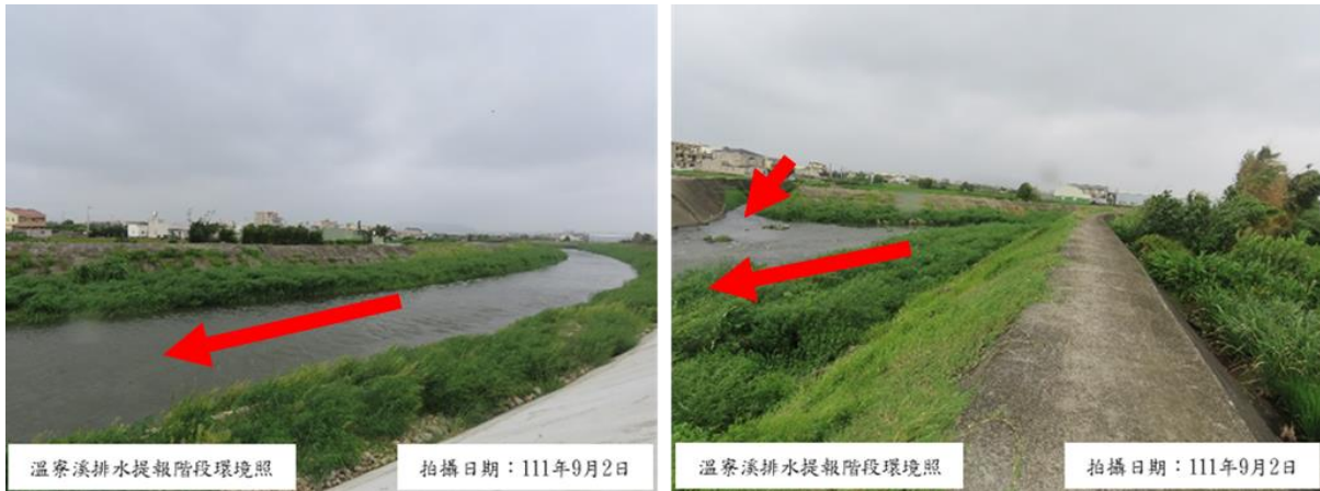
圖 2-70 大安區溫寮溪溫寮橋上游堤防改善應急工程環境照
