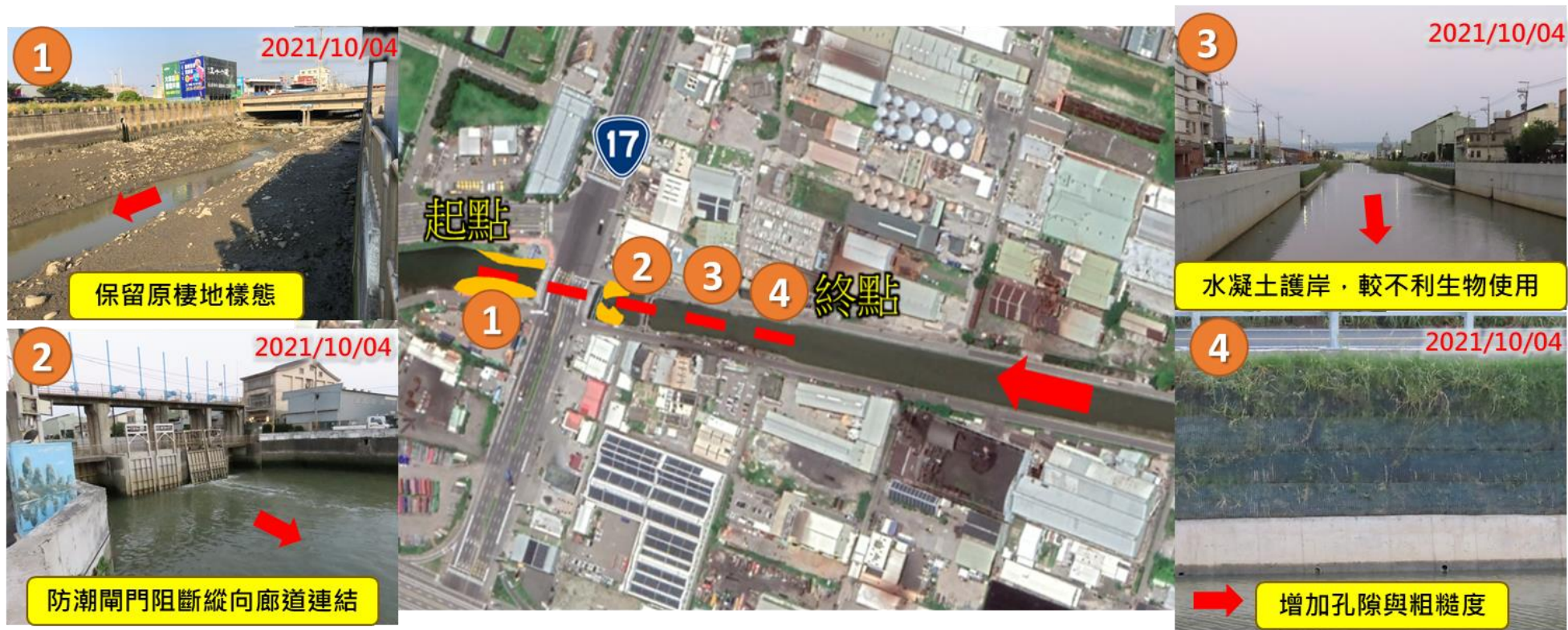
圖 2-80 安良港排水現地情形
