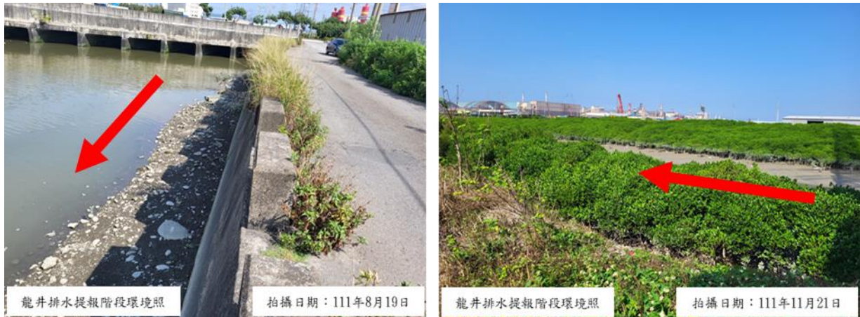
圖 2-63 龍井區龍井排水臨港路下游左岸護岸改善應急工程環境照
