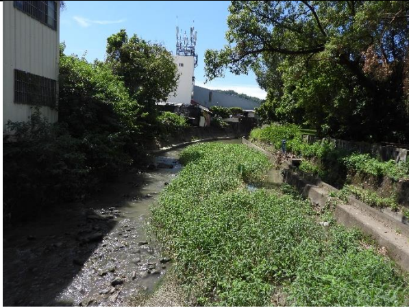
車籠埤預定工區環境狀況 拍攝日期:111年7月6日
