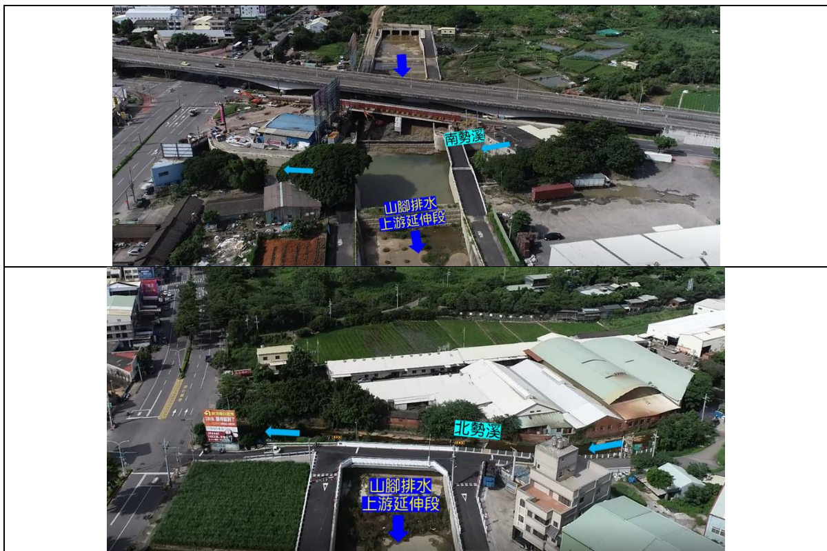
圖 2-28 山腳排水上游延伸段南勢溪及北勢溪分流工應急工程環境照
