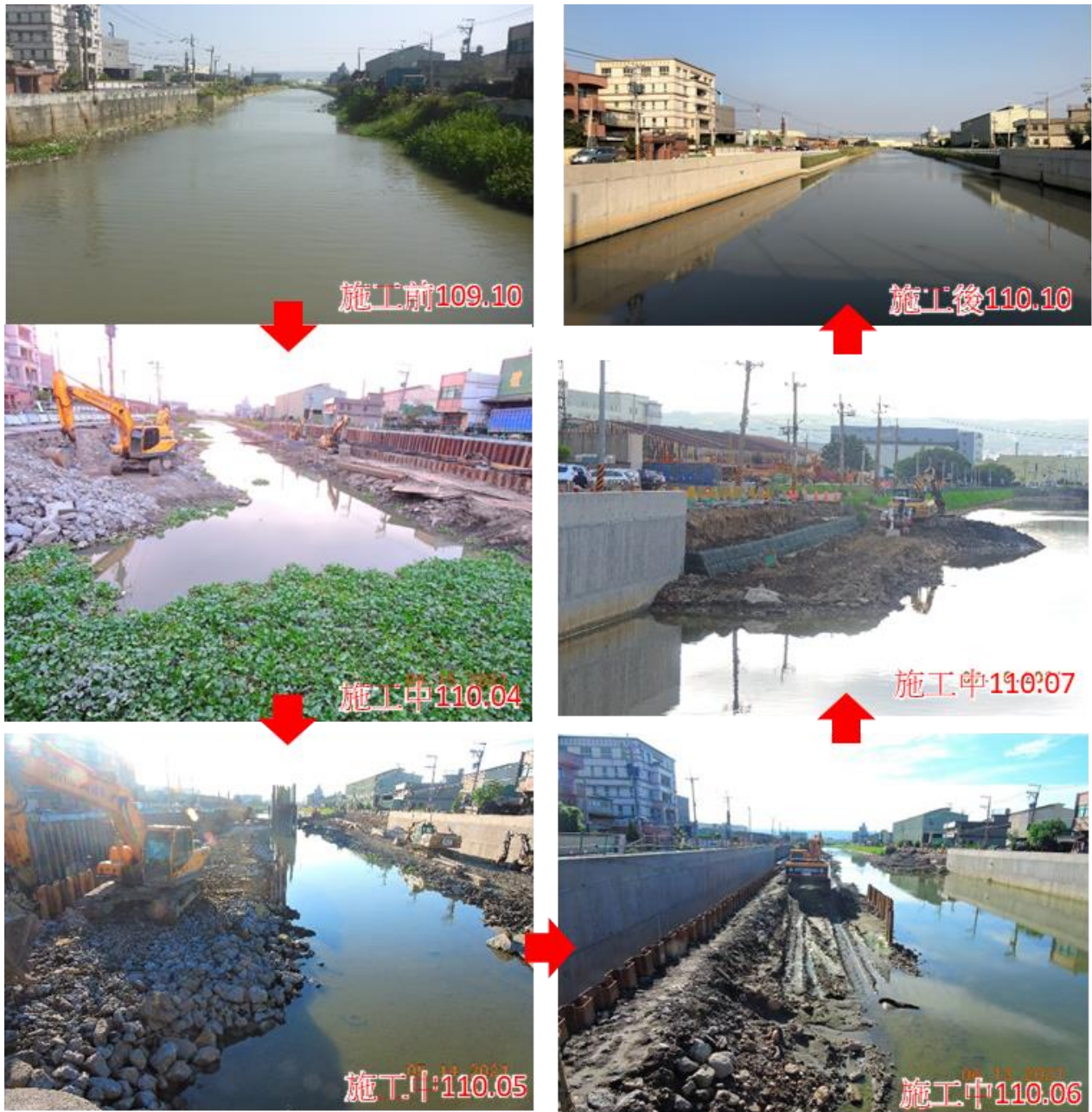
圖 2-81 施工前中後棲地變化(閘門上游)
