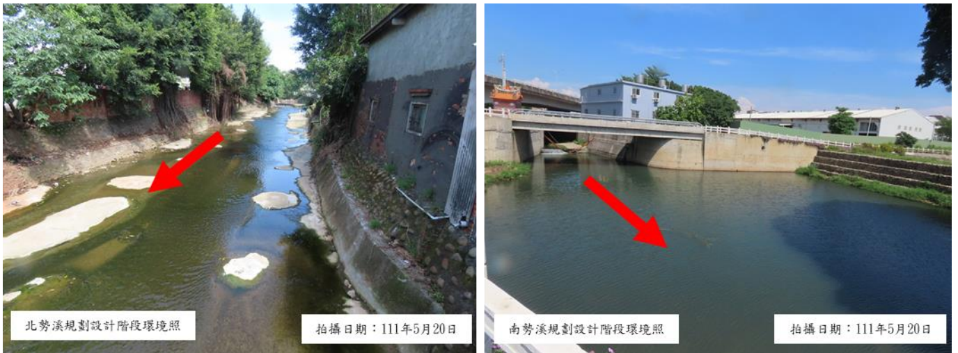
圖 2-29 山腳排水上游延伸段南勢溪及北勢溪分流工應急工程環境照
