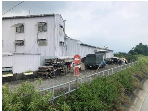
排水路旁之住宅 (拍攝日期 110.07.19)
