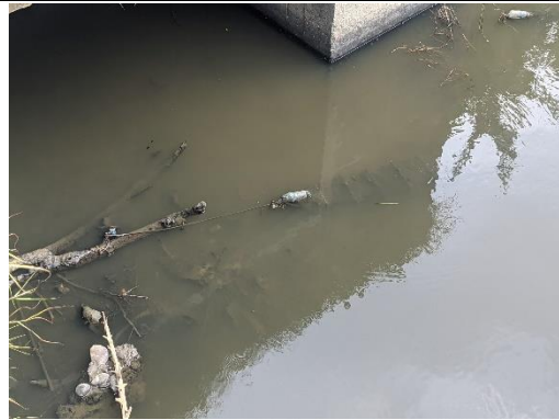
排水路水質混濁且有廢棄物 (拍攝日期 110.07.19)
