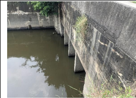
大堀尾排水現有之過水箱涵 (拍攝日期 110.07.19)
