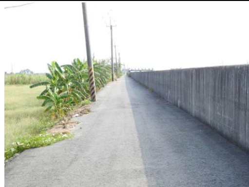
鴨母寮排水周邊道路 (拍攝日期 108 年 10 月 19 日)
