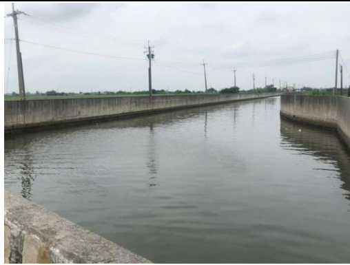
鴨母寮排水 (拍攝日期 108 年 8 月 1 日)
