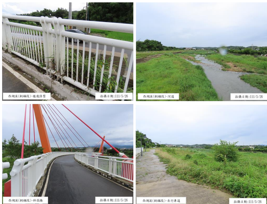
圖 4-17 「西湖溪整體環境營造計畫(銅鑼段)」維管階段自主檢查照片
