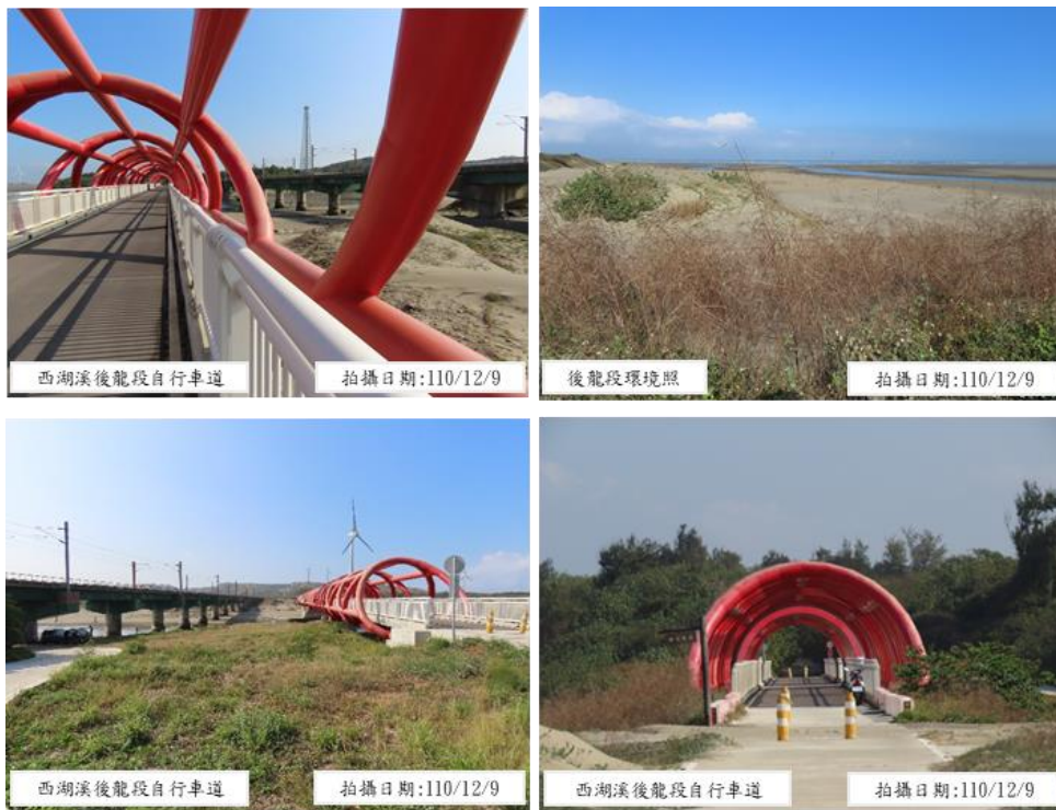
圖 4-19 「西湖溪整體環境營造計畫(後龍段)」維管階段自主檢查照片
