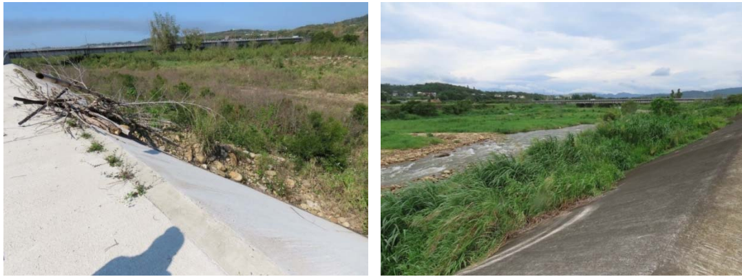
圖 3-11 法龍橋周邊堤防環境照
