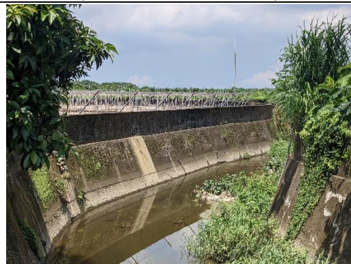
公館排水路現有之水泥護岸 (拍攝日期 110.07.05)
