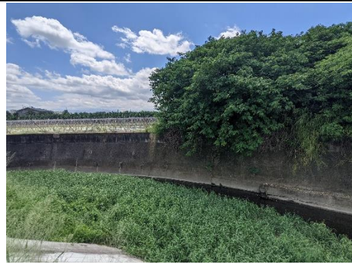
排水路內植被 (拍攝日期 110.07.05)
