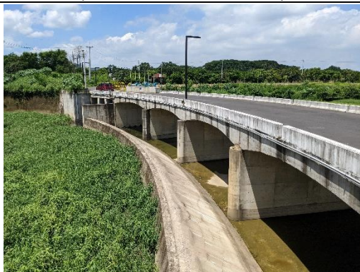
排水路銜接滯洪池箱涵 (拍攝日期 110.07.05)
