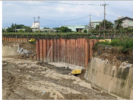
改建之農路橋基座 (拍攝日期 111.05.18)
