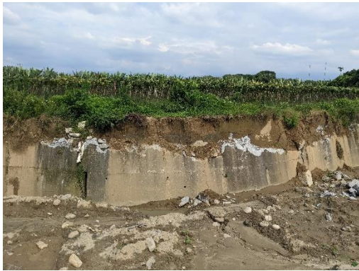
已部分打除的舊有護岸 (拍攝日期 111.05.18)
