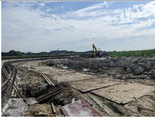
工程之施工便道及資材放置區 (拍攝日期 111.05.18)
