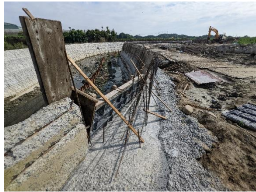
正在施做的護岸 (拍攝日期 111.05.18)
