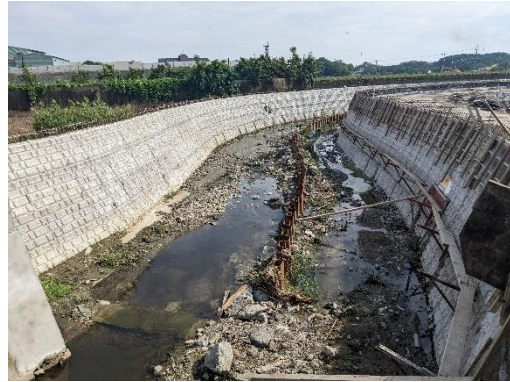
部分區段護岸已完成 (拍攝日期 111.05.18)
