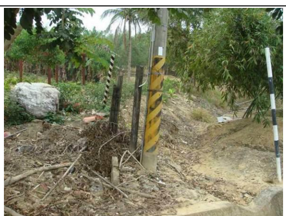
中坑里休憩公園旁擋土牆改善
