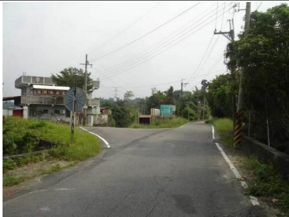
土崎里往烏樹林三叉路口環境改善
