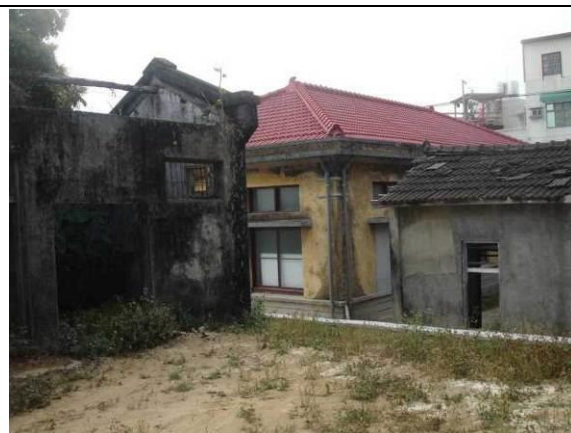
竹炭故事館旁閒置空間修繕為產業文化教室
