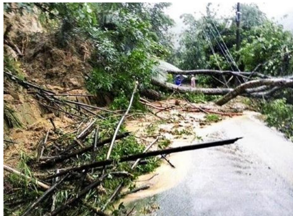
山區道路雨後邊坡坍塌
