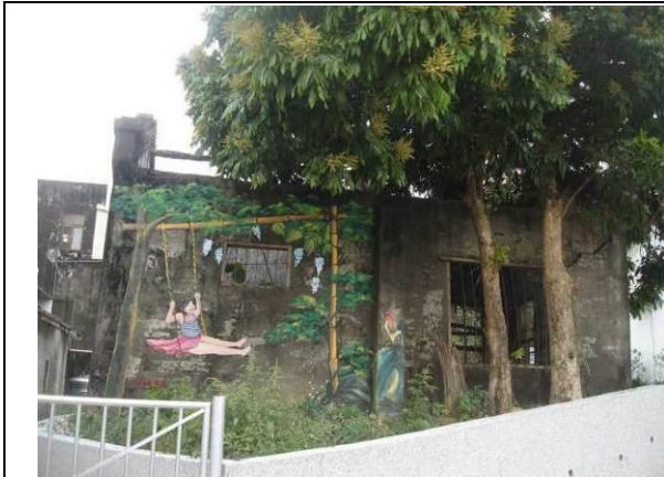
竹炭故事館旁閒置空間修繕為產業文化教室
