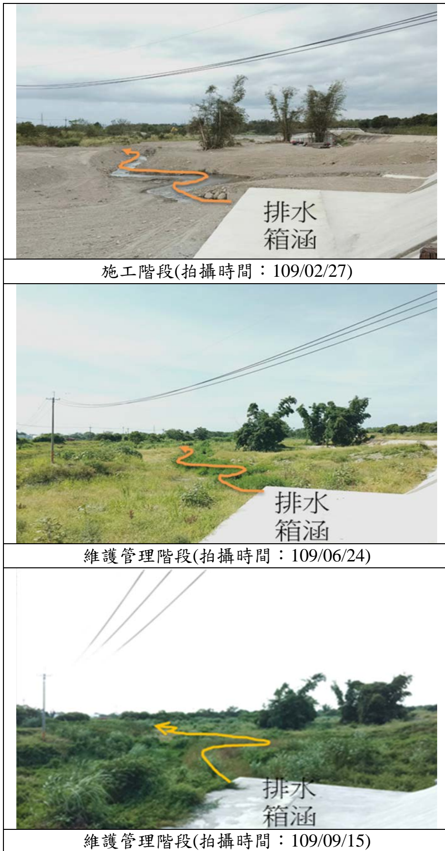
圖 8-5 工區上游段排水箱涵生態恢復情形現況照
