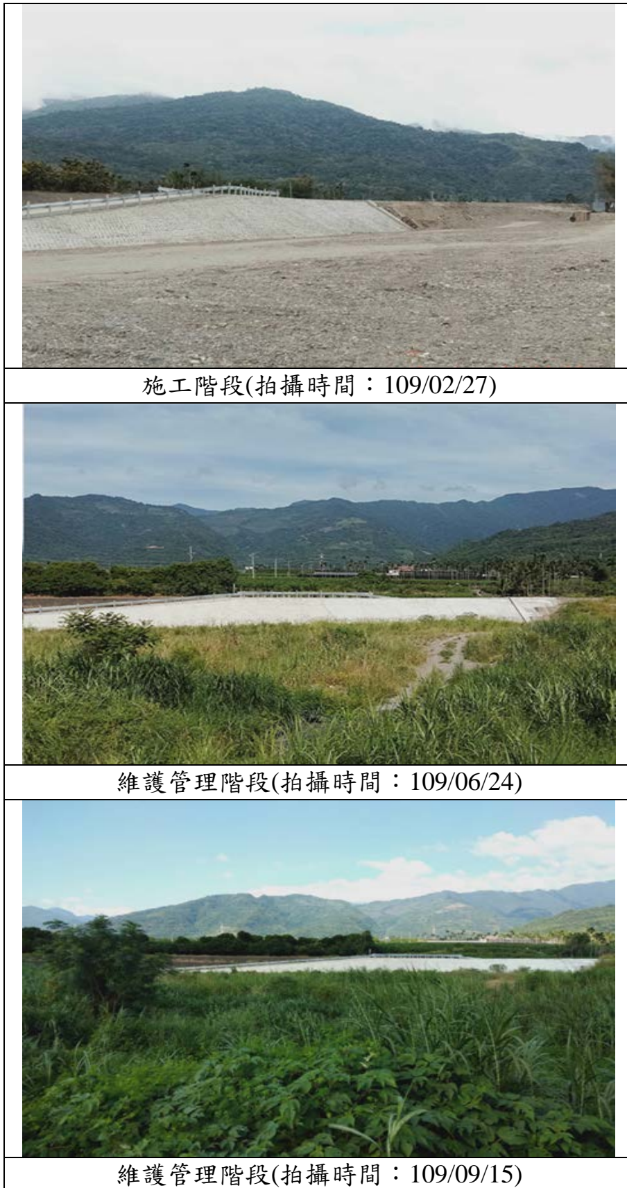
圖 8-7 工區中游段生態恢復情形
