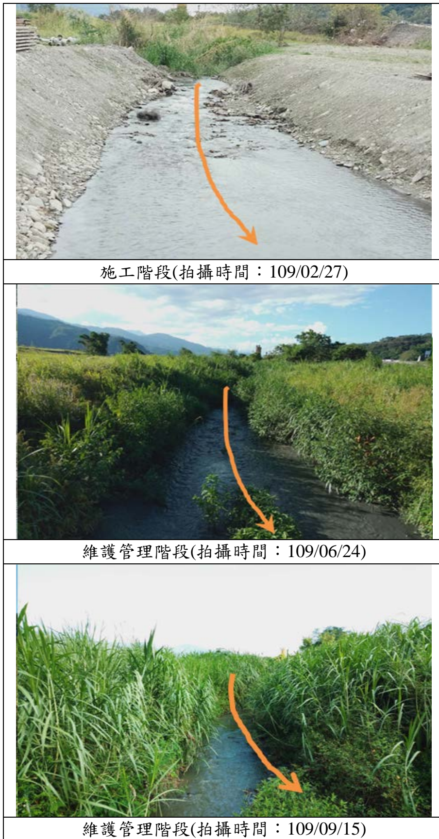
圖 8-8 工區下游段生態恢復情形
