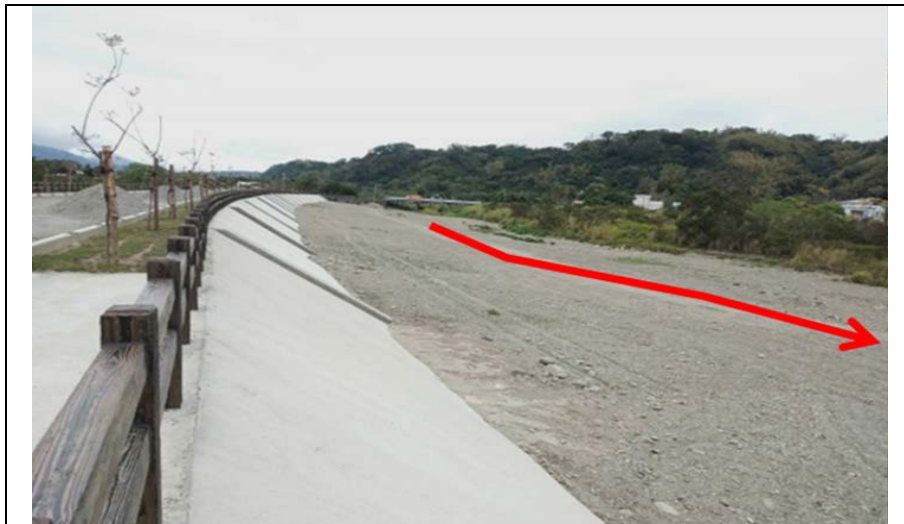
施工階段(拍攝時間：109/02/27)
