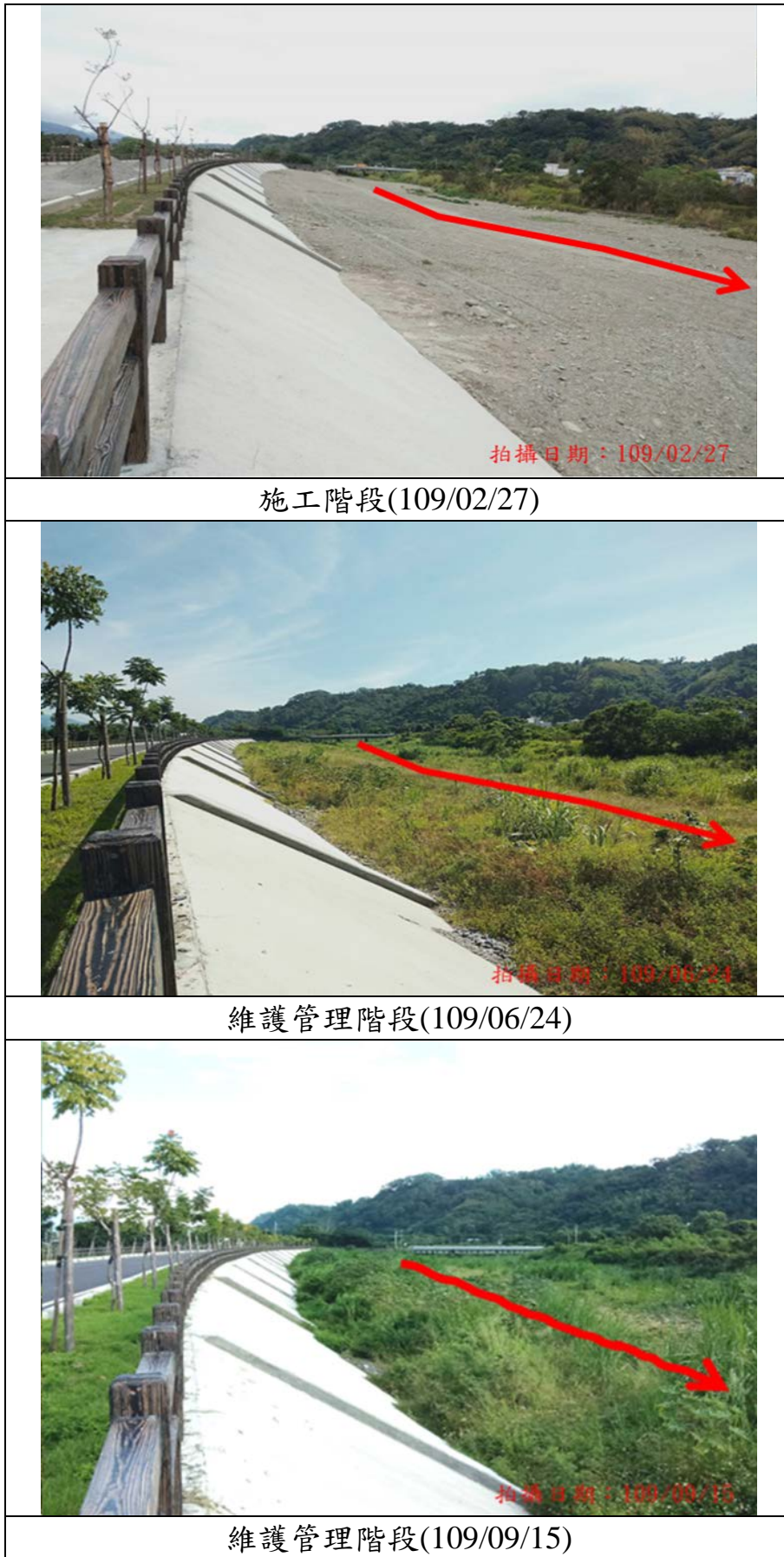
圖 8-4 工區上游段生態恢復情形現況照
