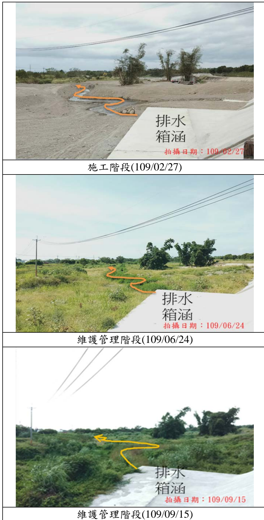
圖 8-5 工區上游段排水箱涵生態恢復情形現況照
