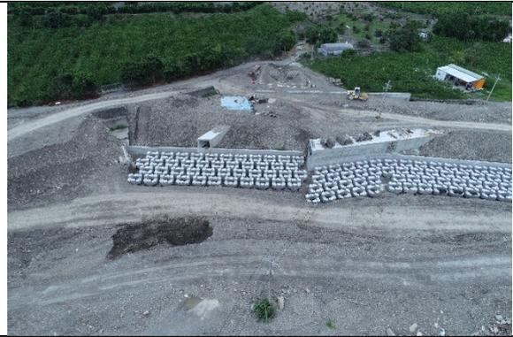
說明：護腳工施作情形，完程度約 50%
