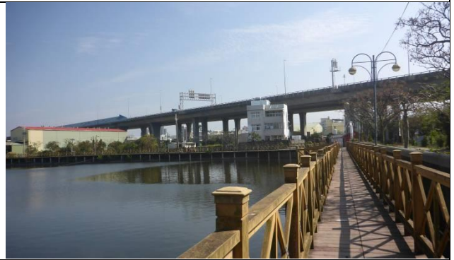
水域測站-計畫區之木製步道
