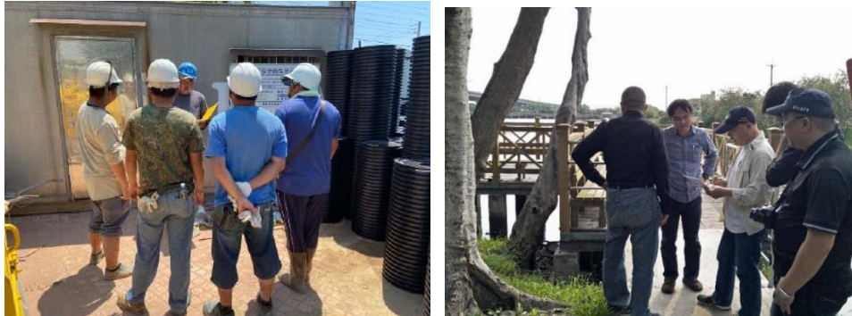
圖 7-6 「鈴木埤親水環境工程改善計畫」施工前宣導照片
