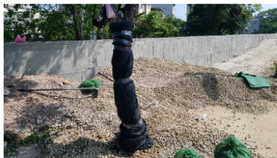
施工位置樹木保護措施
