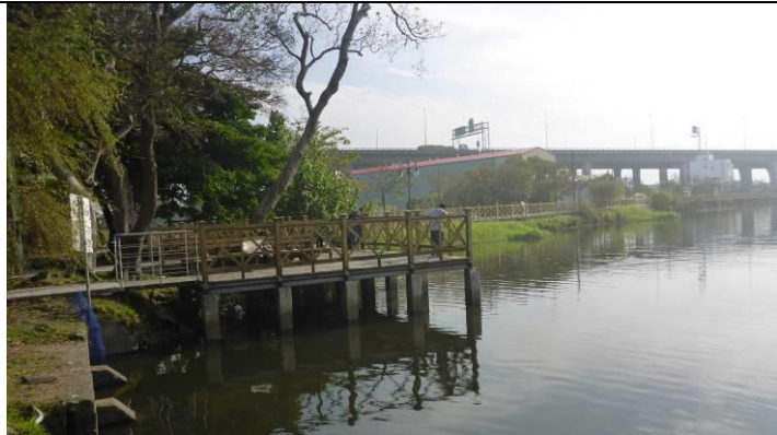
環境照-計畫區之木製平台
