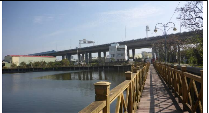
水域測站-計畫區之木製步道
