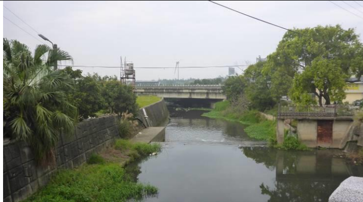
環境照-鄰近區之溝渠(冷水坑)
