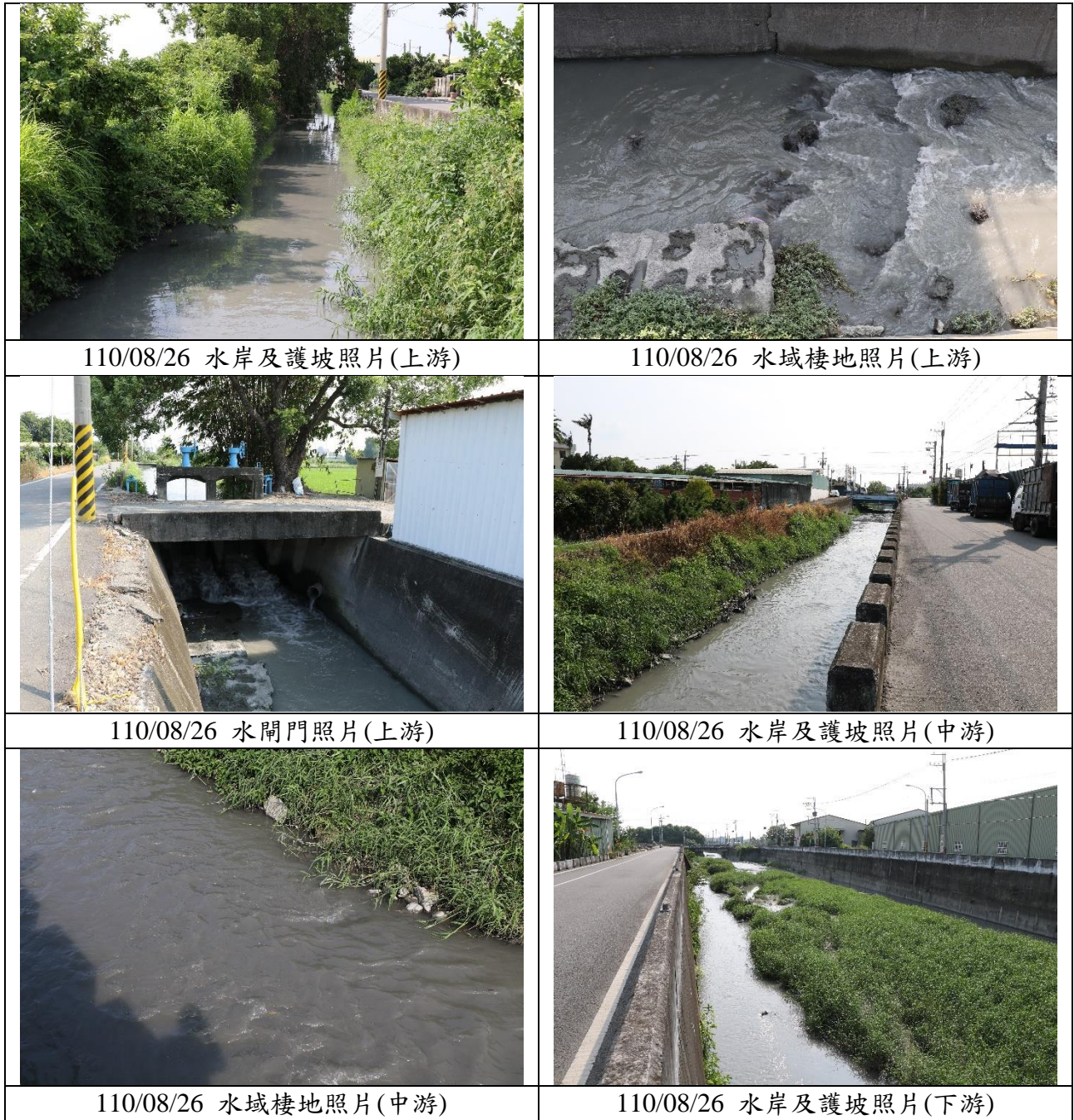
圖 13 卓乃潭排水(第一期)改善工程(0K+000~3K+468)
