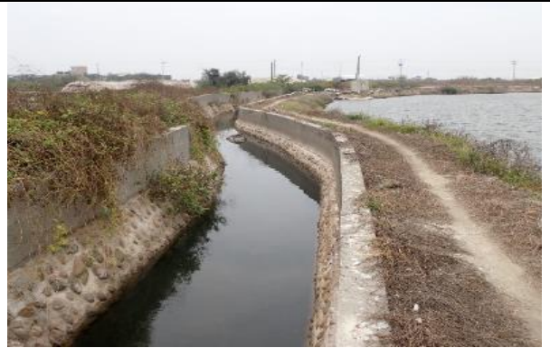
水岸及護坡照片
