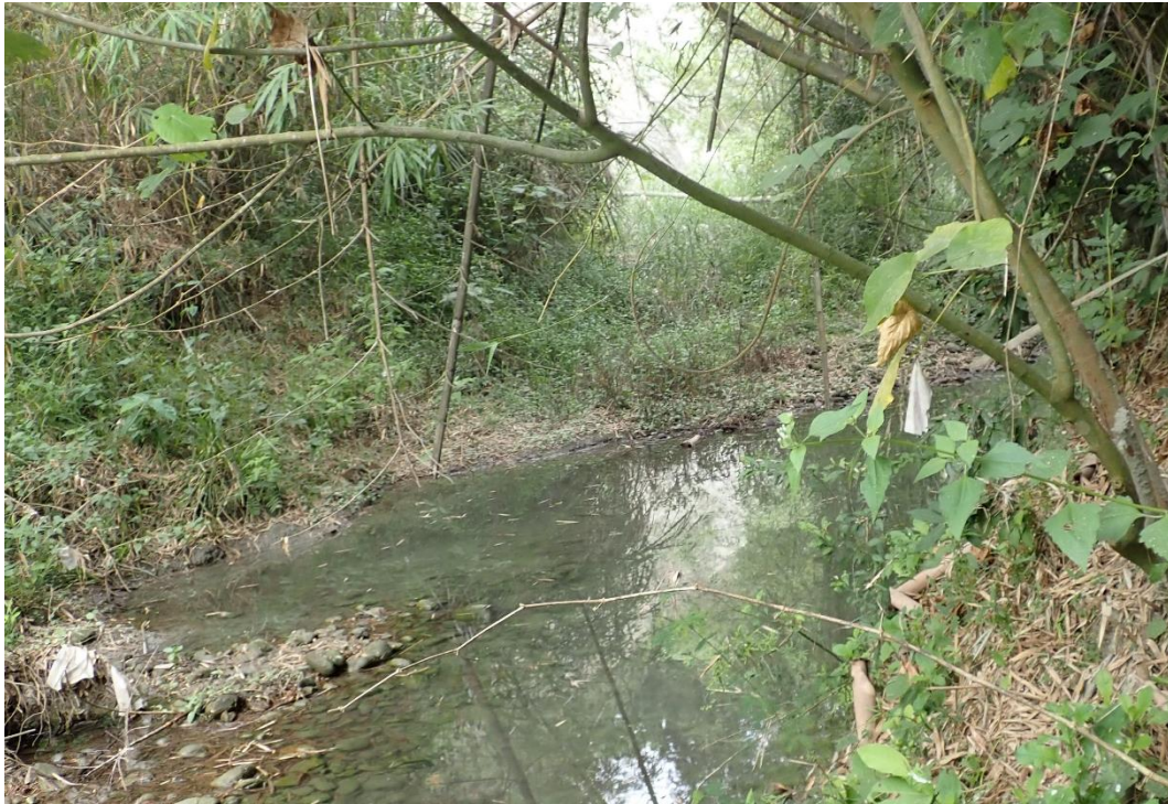
圖 5-60、二仁溪夏梅林橋上下游段整體改善工程 B、C 工區河岸現況
