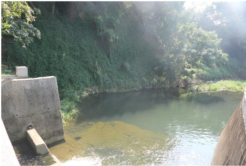
圖 3-20 南勢溪預定工程區域終點處(汙水接管後排放口)兩岸現況照片
