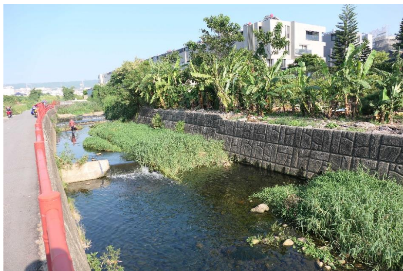
圖 3-19 南勢溪預定工程區域起點處(鄰汙水排放口)兩岸現況照片
