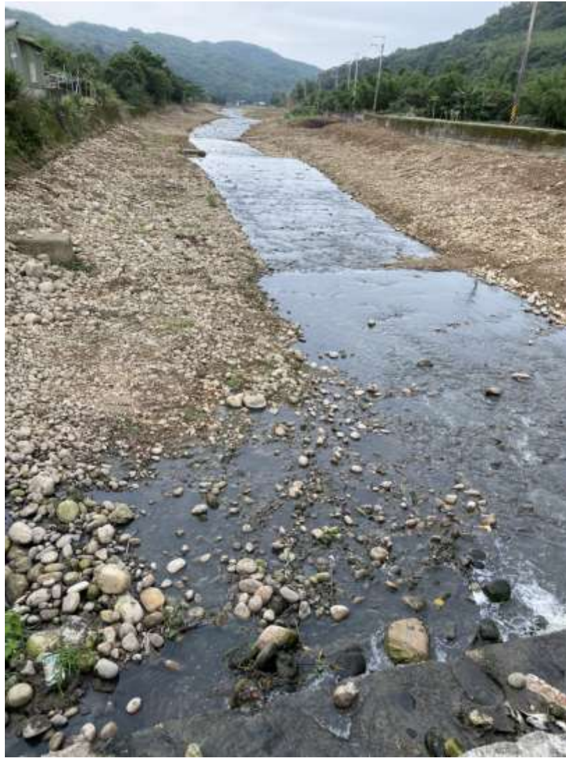
瑞樹坑溪便橋
