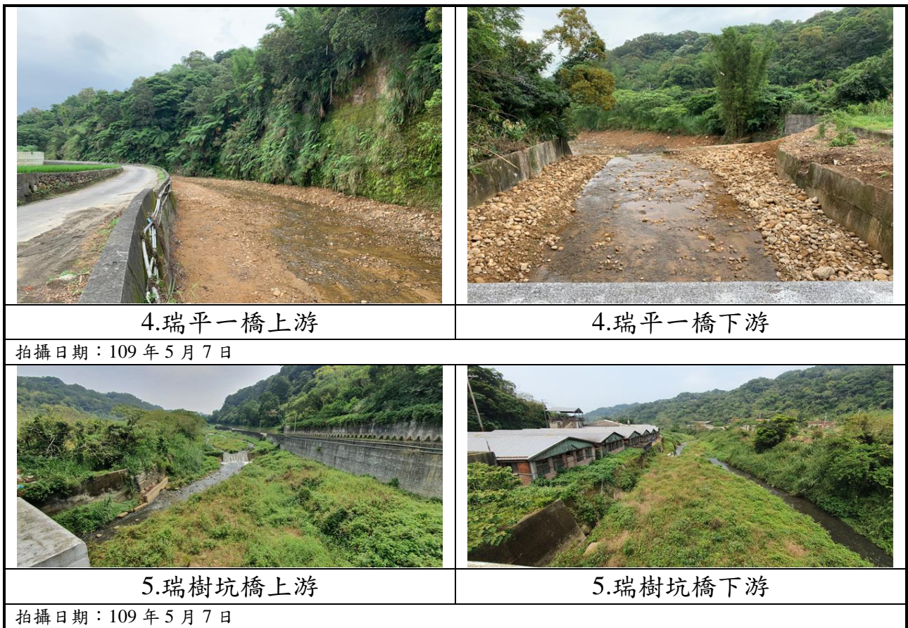
圖 3-1 瑞樹坑溪河岸現況
