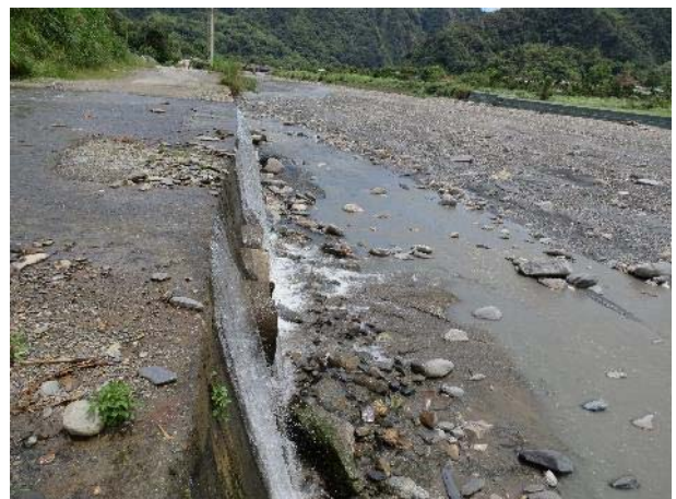
右岸堤防現況
