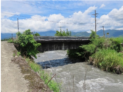
宜蘭安農溪環境照-明星橋
