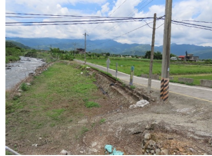
宜蘭安農溪環境照-雙賢二號橋北側腹地
