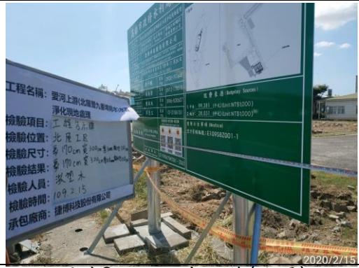
照片2：工程告示牌(北屋) (民國 109 年 2 月 15 日)
