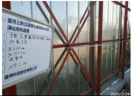
照片4：施工圍籬(北屋) (民國 109 年 2 月 24 日)
