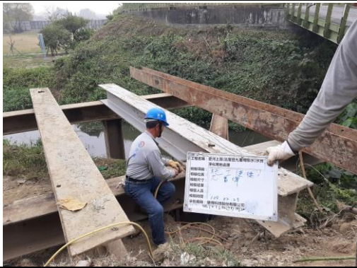
照片5：施工便橋(九番埤) (民國 109 年 2 月 23 日)
