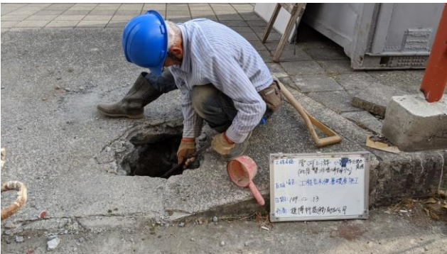
照片5：工程告示牌基礎挖掘(九番埤) (民國 109 年 2 月 13 日)
