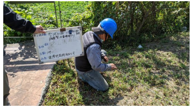
照片2：九番埤濕地公園施工圍籬放樣拉水線 (民國 109 年 1 月 30 日)
