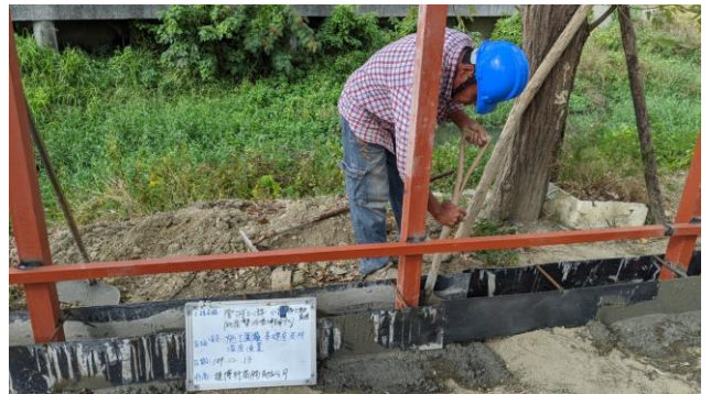
照片6：施工圍籬防溢座澆置(九番埤) (民國 109 年 2 月 13 日)
