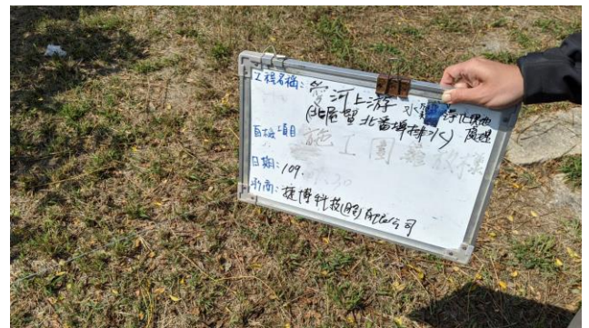
照片4：九番埤濕地公園施工圍籬放樣拉水線 (民國 109 年 1 月 30 日)
