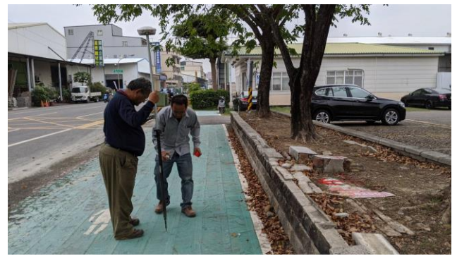
照片4：測量放樣 (民國 108 年 12 月 31 日)
