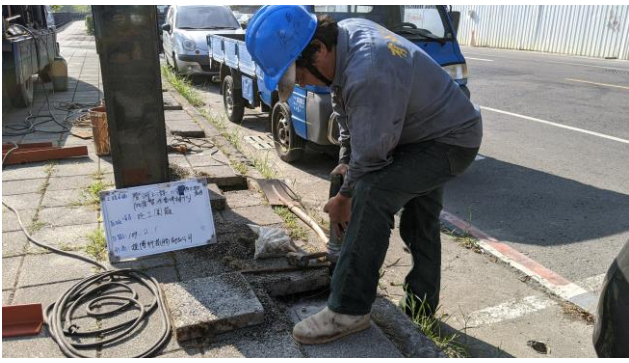
照片1：施工圍籬施作(九番埤) (民國 109 年 2 月 1 日)
