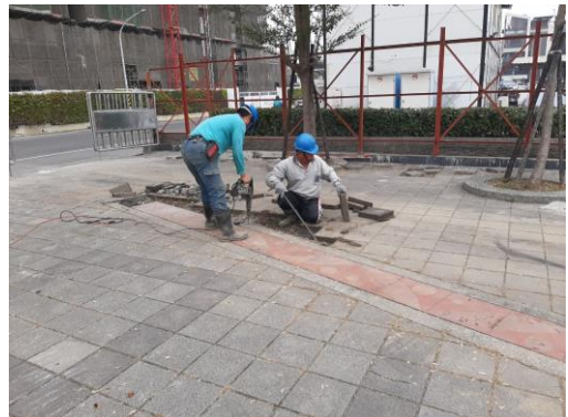
照片4：施工便橋前置作業(九番埤) (民國 109 年 2 月 11 日)
