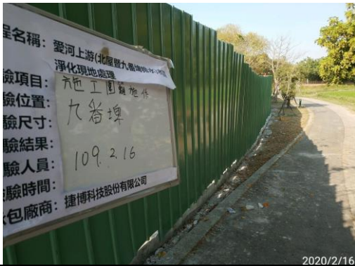
照片3：施工圍籬(九番埤) (民國 109 年 2 月 16 日)
