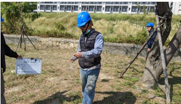
照片3：九番埤濕地公園施工圍籬放樣拉水線 (民國 109 年 1 月 30 日)
