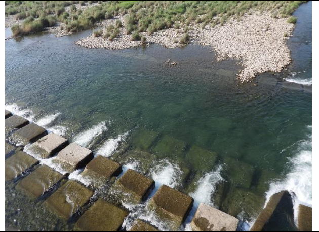
水岸及護坡照片
