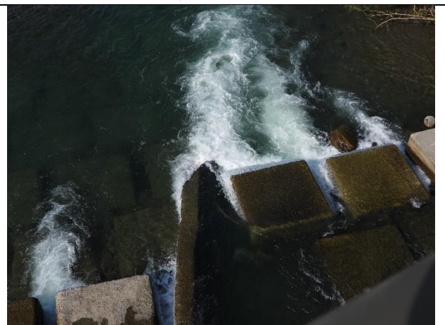
水岸及護坡照片
