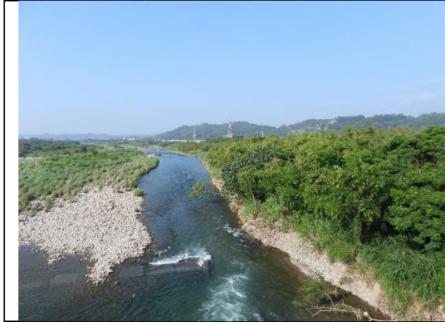
水岸及護坡照片
