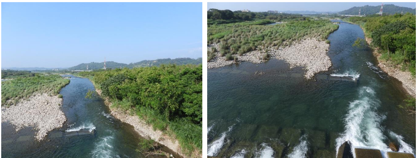
圖 22、後龍溪流域之新東大橋往下游方向現況照片(點位 A)
