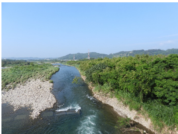
水岸及護坡照片
