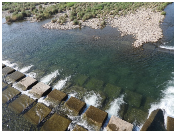
水岸及護坡照片
