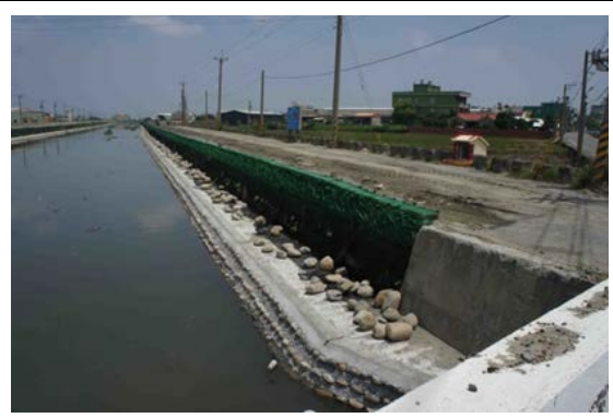
說明：下游護岸工程，下層混凝土鑲嵌圓石，上層沙包堆砌，以及堆置大粒徑石塊作為緩衝。
