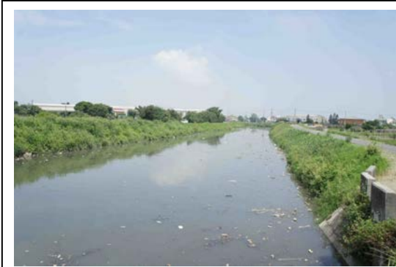
說明：兩側土堤植被茂盛，水質混濁有漂浮垃圾
